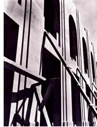
“EDIFICIO CON ANDAMIOS” de Tina Modotti, (1926).
