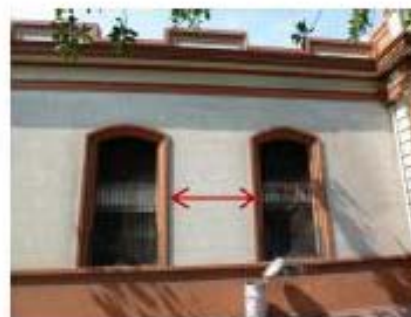
Fachada Principal Sobre Avenida. Ignacio Allende
