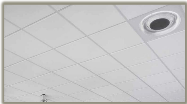
TECHO DE FIBINERAL US ARCE
