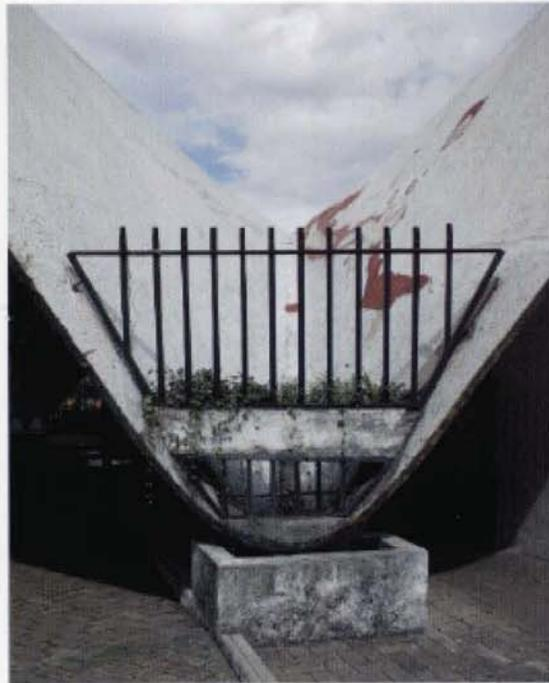
I.100. Detalle de la unión en la actualidad con las protecciones y la canalización del agua a la coladera..
