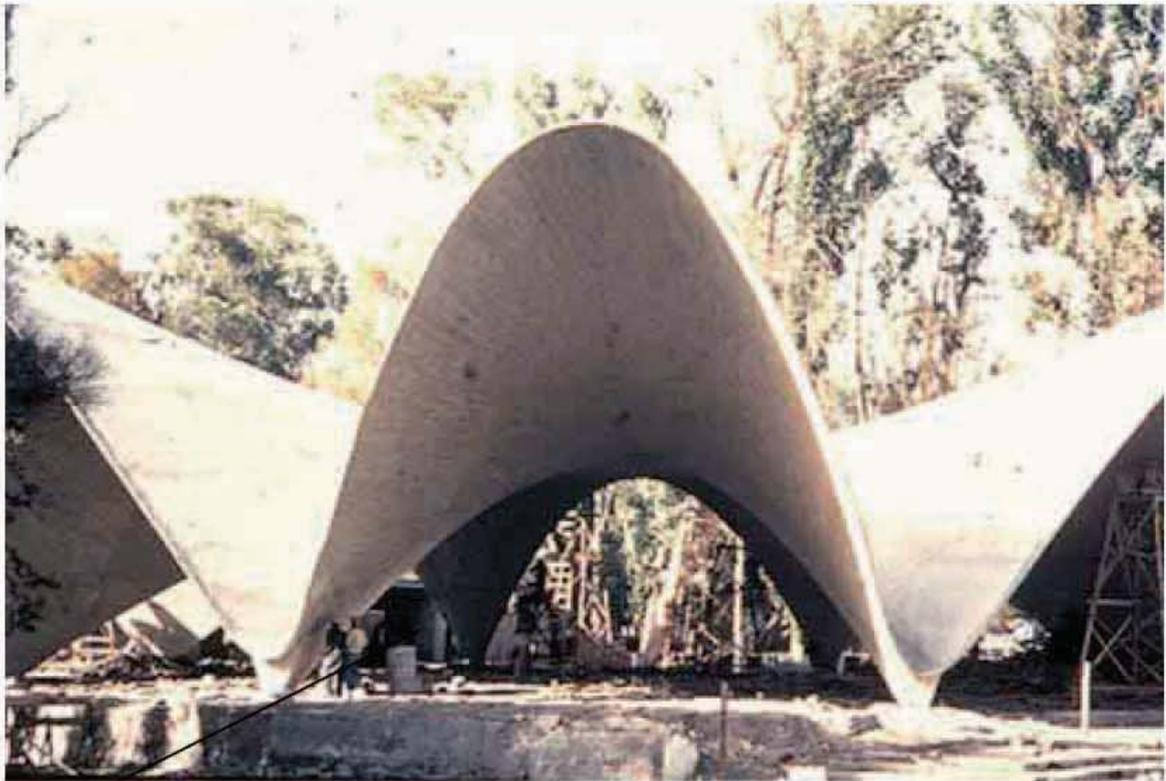
I.103. Esta imagen nos muestra una etapa anterior de la cubierta si la comparamos con la I.55. Aquí aun no se ha colocado el firme de concreto, y en el fondo se aprecia la construcción del edificio de Servicios.
