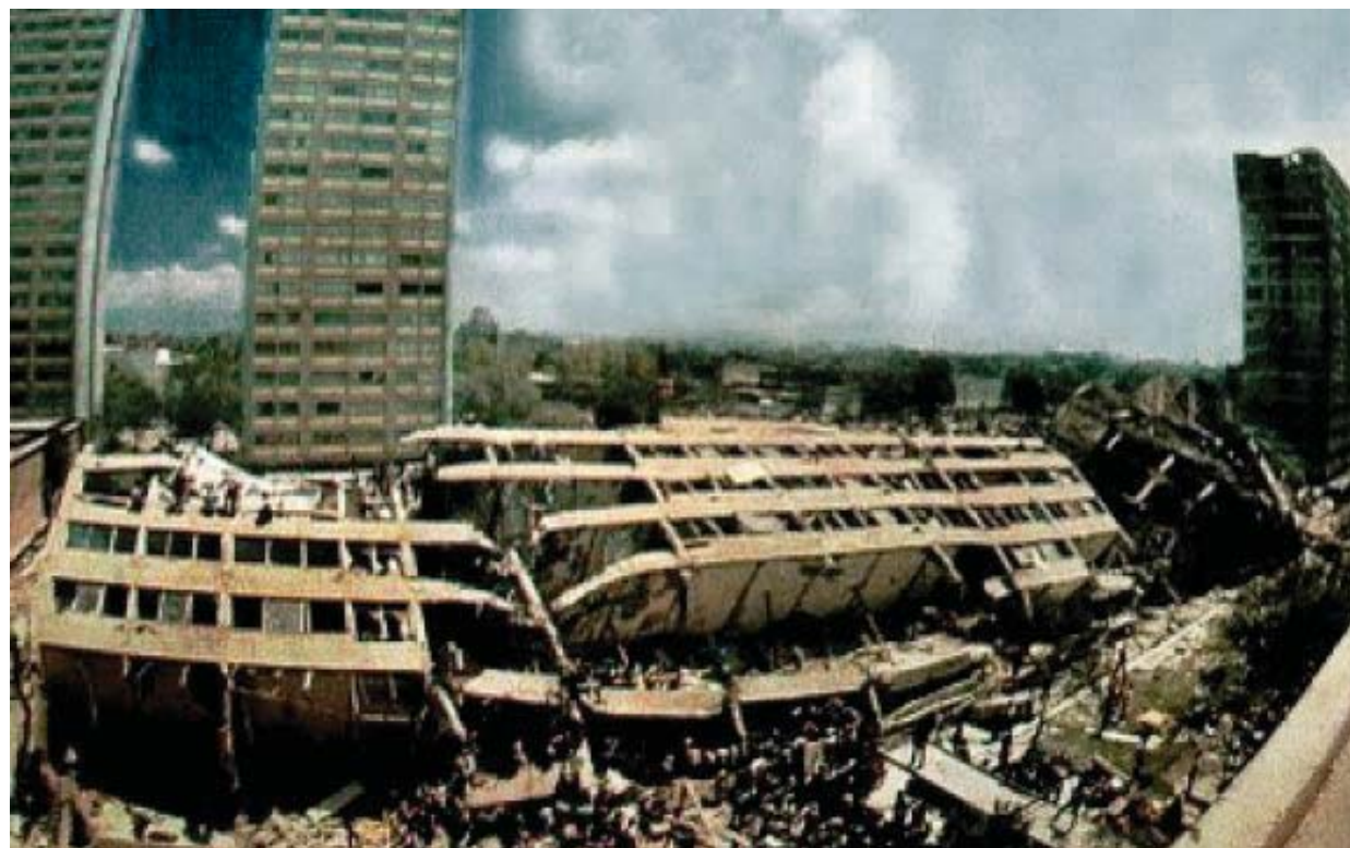
Gráfico 6. Edificio Nuevo León colapsado...
