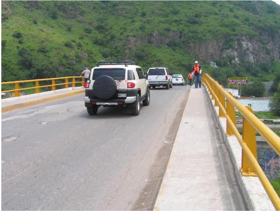
*Fig. 5.4 Carpeta asfáltica dañada donde se pueden observar baches*
