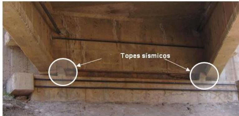
*Fig. 3.19 Topes sísmicos en el lado interior de las pilas (Jara et al., 2011)*
