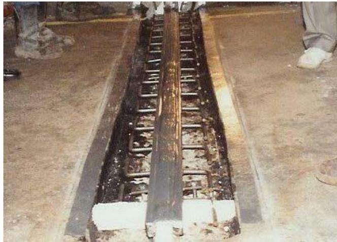
*Fig. 3.24 Reemplazamiento de una junta de expansión de un puente (Chhabra, 2004)*
