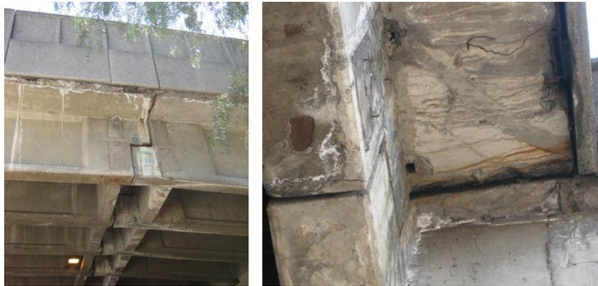
*Fig. 1.19 Problemas de corrosión en la superestructura por drenaje pluvial deficiente*
