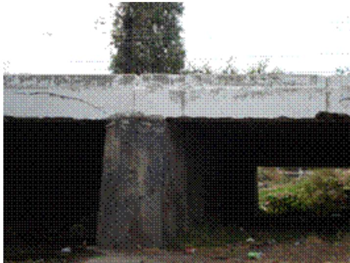
*Fig. 2.11 Daño por vibración en la calzada del puente Palo Alto IV, Carretera Morelia-Guadalajara (Hernández et al., 2009)*
