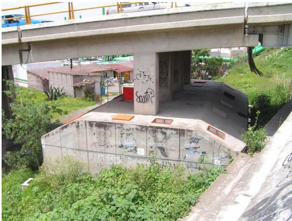
*Fig. 5.7 Pila No. 5 con un cajón que representa una re-cimentación debido a los hundimientos que se estaban presentando*
