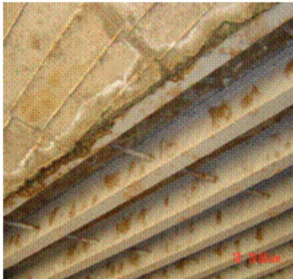
*Fig. 2.9 Manchas de óxido en el sistema de piso, señal de corrosión en el refuerzo
