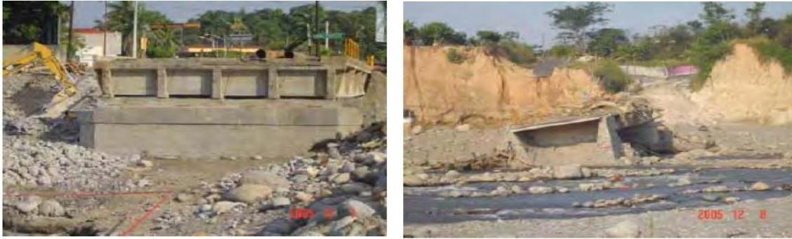
*Fig. 1.23 Puentes colapsados Coatán y Colonia Obrera (Rivera et al., 2006)*
