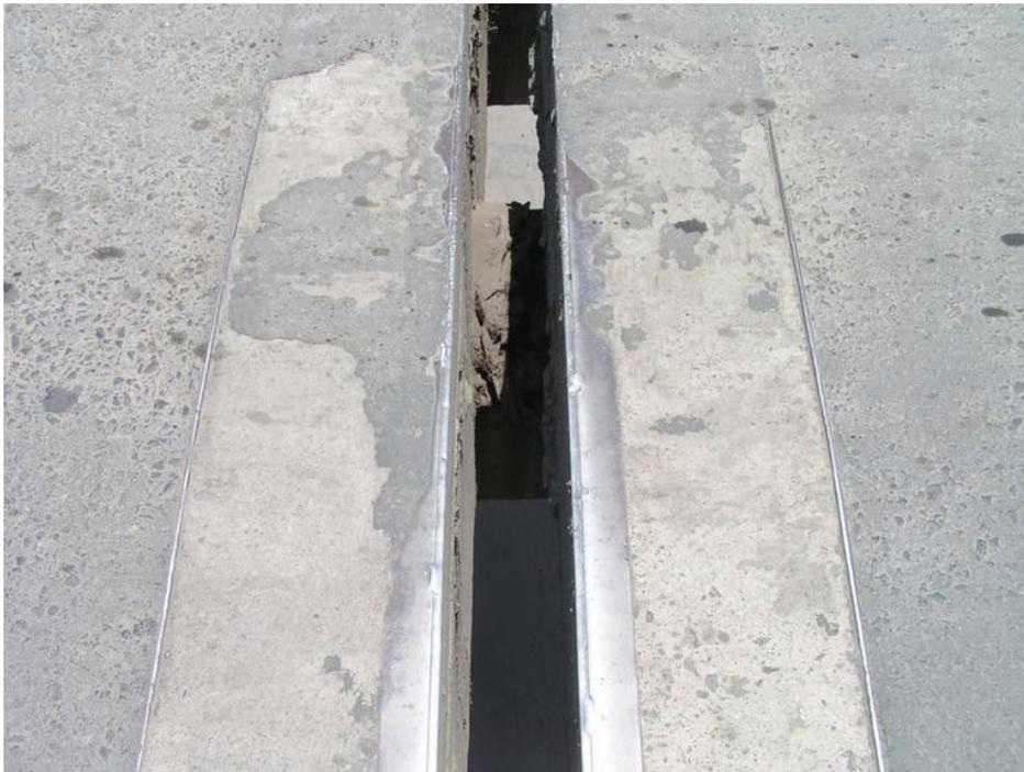
*Fig. 5.13 Junta de expansión sobre el tramo 2-3*
