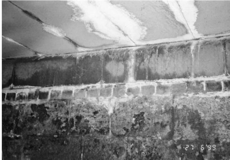
*Fig. 2.10 Eflorescencia del concreto debido a lixiviación en la parte baja de la superestructura (Ryall, 2001)*
