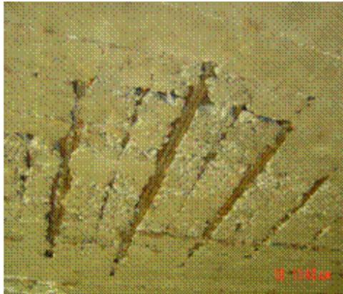
***Fig. 1.17 Daño en la losa del puente “Chilchota” (Hernández et al., 2009)***
