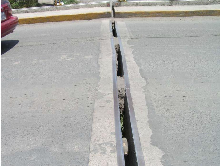
*Fig. 5.12 Junta de expansión sobre el tramo 1-2*
