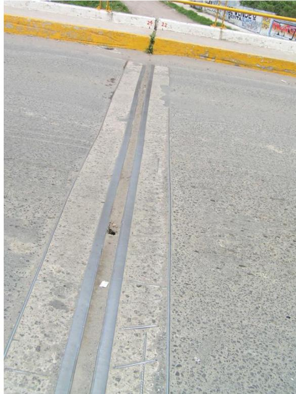
*Fig. 5.11 Junta de expansión sobre el estribo No. 1*
