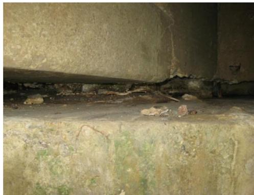
***Fig. 1.18 Problemas de corrosión en apoyos***
