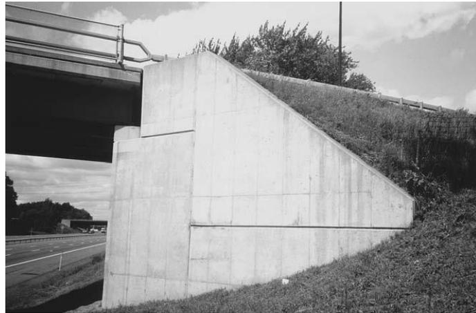
*Fig. 1.11 Muro posterior integrado con un muro ala en un estribo de concreto (Tonias, 2003)*
