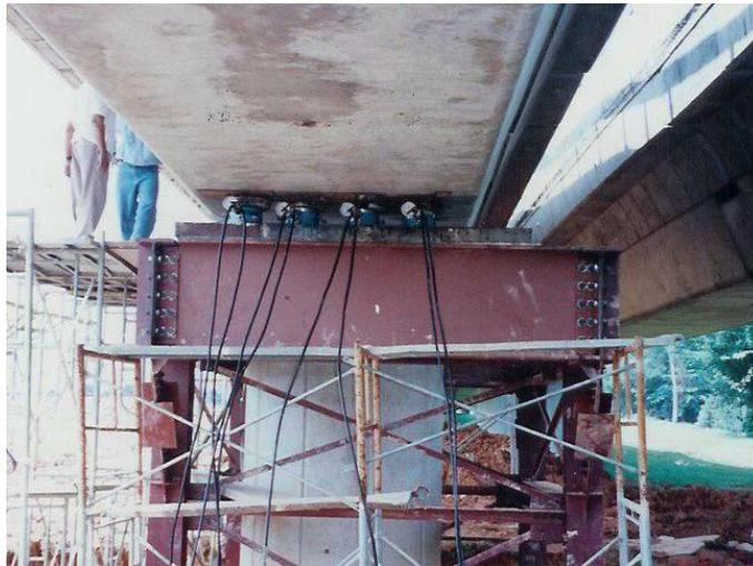
*Fig. 3.25 Sistema de gatos hidráulicos para el reemplazamiento de apoyos de un puente (Chhabra, 2004)*
