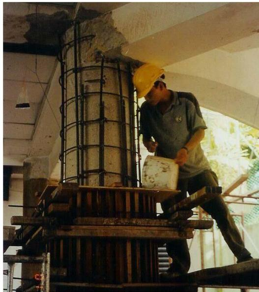
*Fig. 3.20 Rehabilitación de una columna con encamisado de concreto (Chhabra, 2004)*
