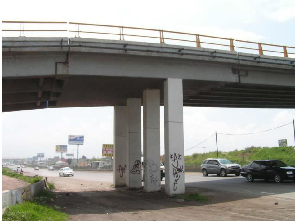
*Fig. 5.6 Pila No. 2 de cuatro columnas que presenta movimientos y deflexiones ante cargas pesadas*
