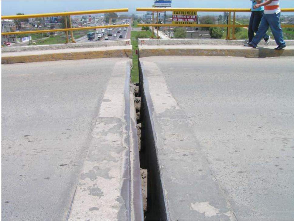
*Fig. 5.14 Junta de expansión entre el tramo suspendido y metálico y el volado de la pila No. 3-4*
