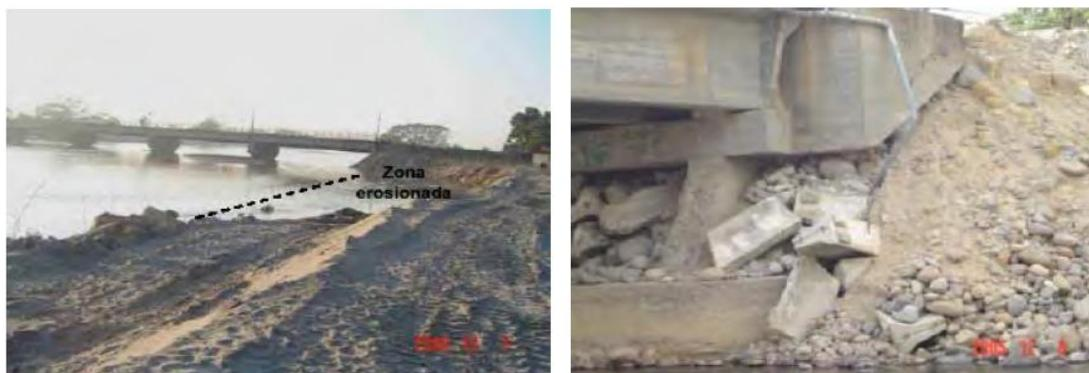
*Fig. 1.22 Daño severo en los puentes de Ciudad Hidalgo y Huehuetán (Rivera et al., 2006)*
