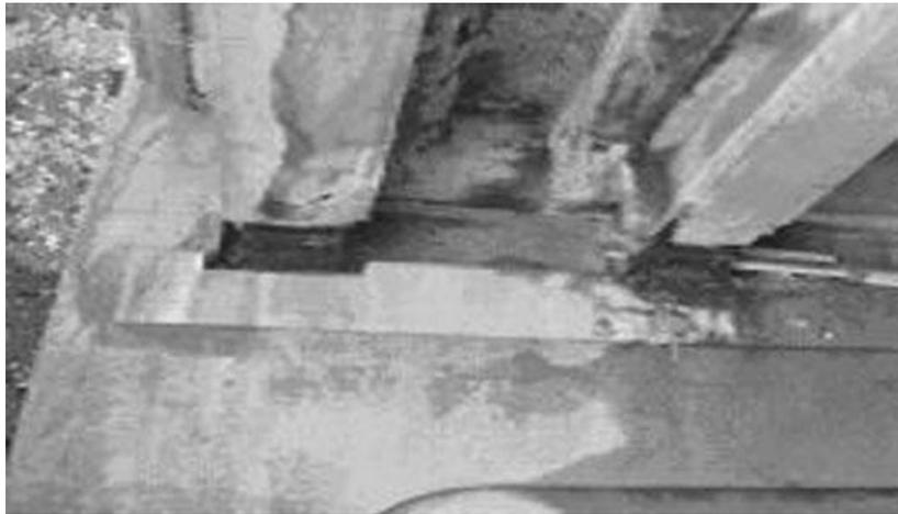
*Fig. 2.16 Apoyos con corrosión que deben remplazarse (Khan, 2010)*
