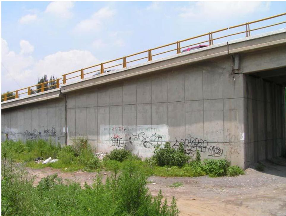
*Fig. 5.9 Asentamiento del acceso al paso en el tramo 6-7 del puente*
