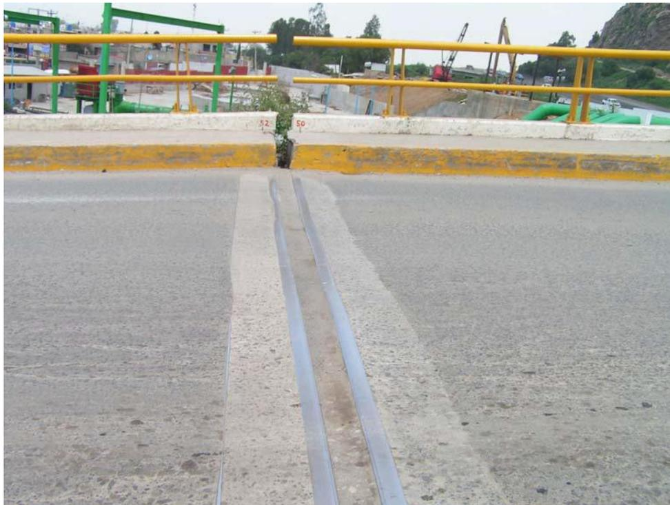
*Fig. 5.15 Junta de expansión sobre el estribo No. 6*
