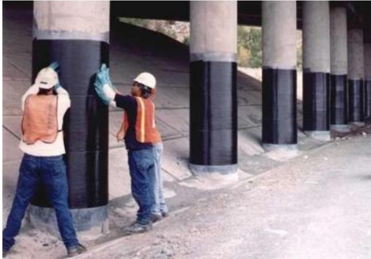
*Fig. 3.22 Encamisado de columnas con FRP (Jara et al., 2011)*
