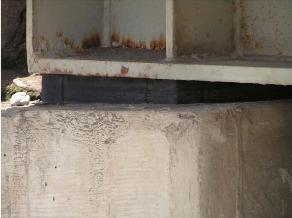
*Fig. 5.10 Apoyo de neopreno donde se puede observar el estado de deterioro*
