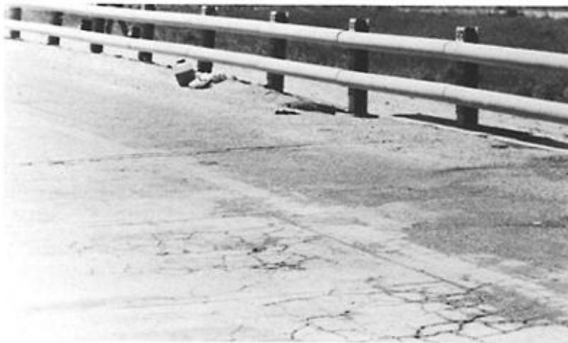
*Fig. 2.12 Agrietamiento en la superficie de rodamiento (Harding et al.,1990)*
