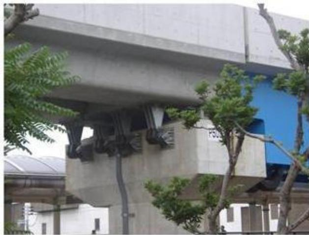
***Fig. 3.18 Elementos para restringir el desplazamiento longitudinal (Jara et al., 2011)***
