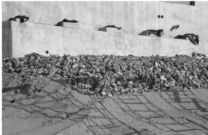
***Fig. 1.12 Estribo protegido con fragmentos de roca***
