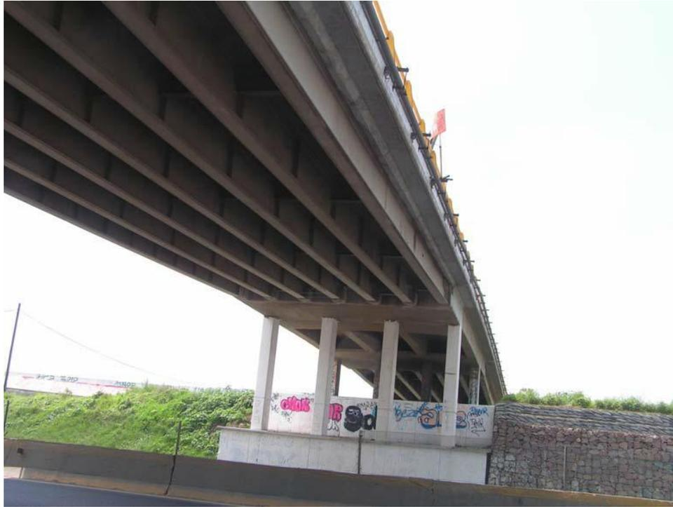
*Fig. 5.8 Pila No. 3-4 con hundimientos hacia el lado del estribo No. 6, y ligero desplome de las comunas hacia ese lado*
