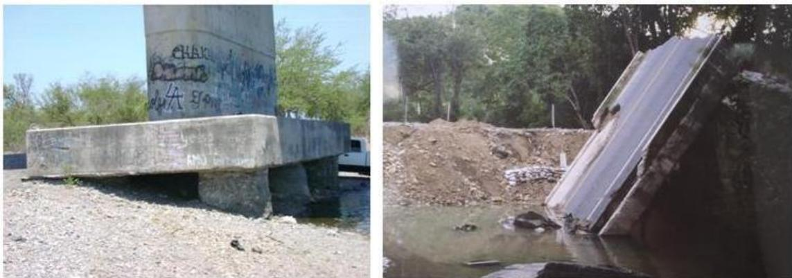
*Fig. 1.24 Falla en puentes por socavación de pilas (Jara et al., 2011)*
