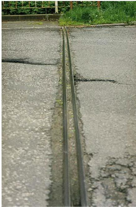
*Fig. 2.15 Efecto del carrilamiento en una junta de expansión (Ryall, 2001)*
