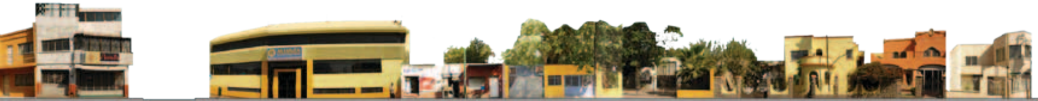
ESTADO ACTUAL FACHADA NORTE DE LA CALZADA DE LOS NIÑOS HÉROES
