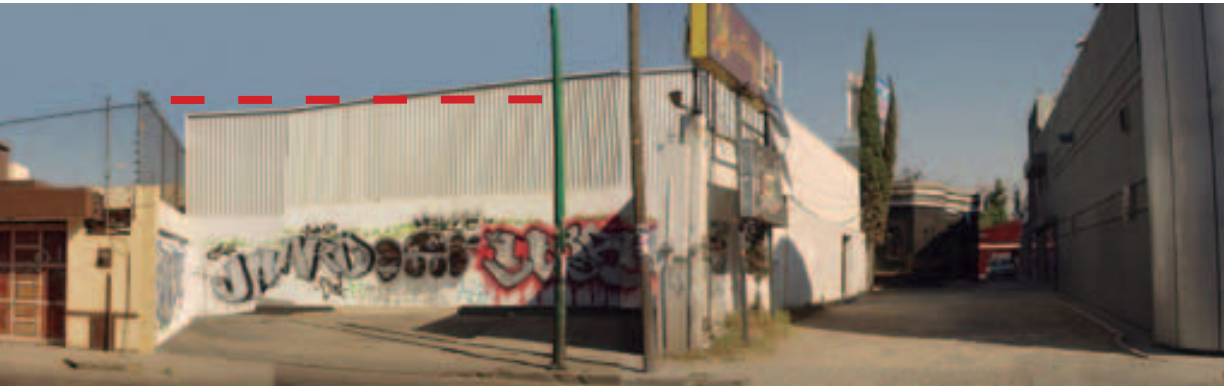
PERFIL 4. BODEGA Y SITIO ABANDONADO
