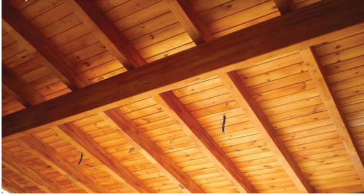
TECHO DE MADERA. INTERIOR
