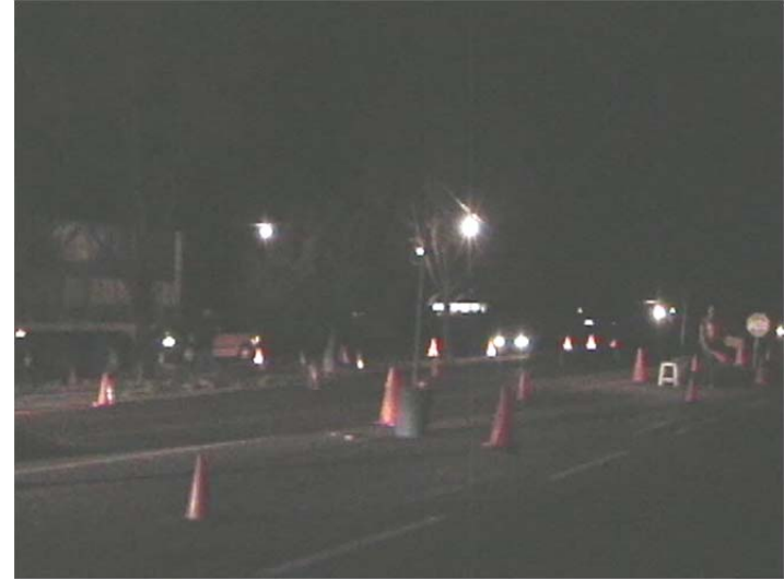
Estación OD Aeropuerto iluminación turno nocturno
