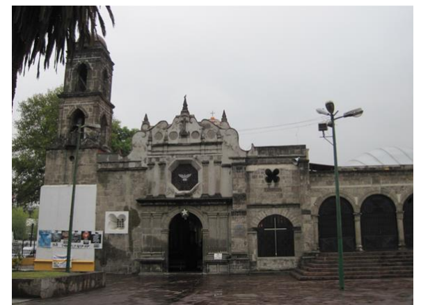
Figura 19 Hundimiento diferencial, Parroquia de San Bartolomé Apóstol (marzo, 2012)
