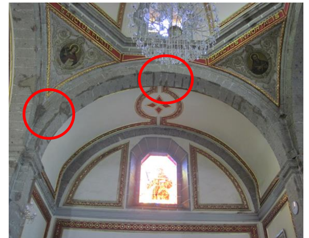
Figura 17 Unión de juntas con mortero, Parroquia de San Bartolomé Apóstol (marzo, 2012)
