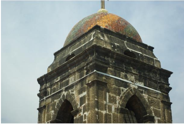
Figura 20 Refuerzo con zunchos en el campanario, Parroquia de San Bartolomé Apóstol (marzo, 2012)
