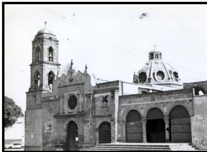
Figura 8 Fachada principal a mediados de los ochenta (INAH, 2012)
