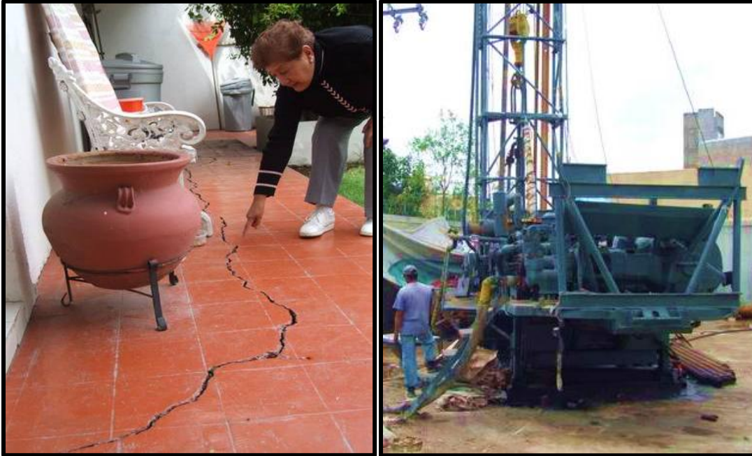
Figura 4.11.- Grieta producida por las vibraciones causadas por maquinarias en obras de perforación de pozos profundos de agua potable. Tecámac, Estado de México.
