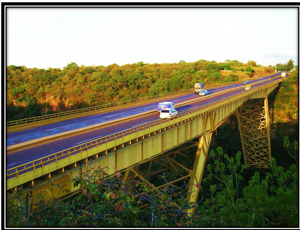
Figura 5.2.- Puente Fernando Espinosa.
