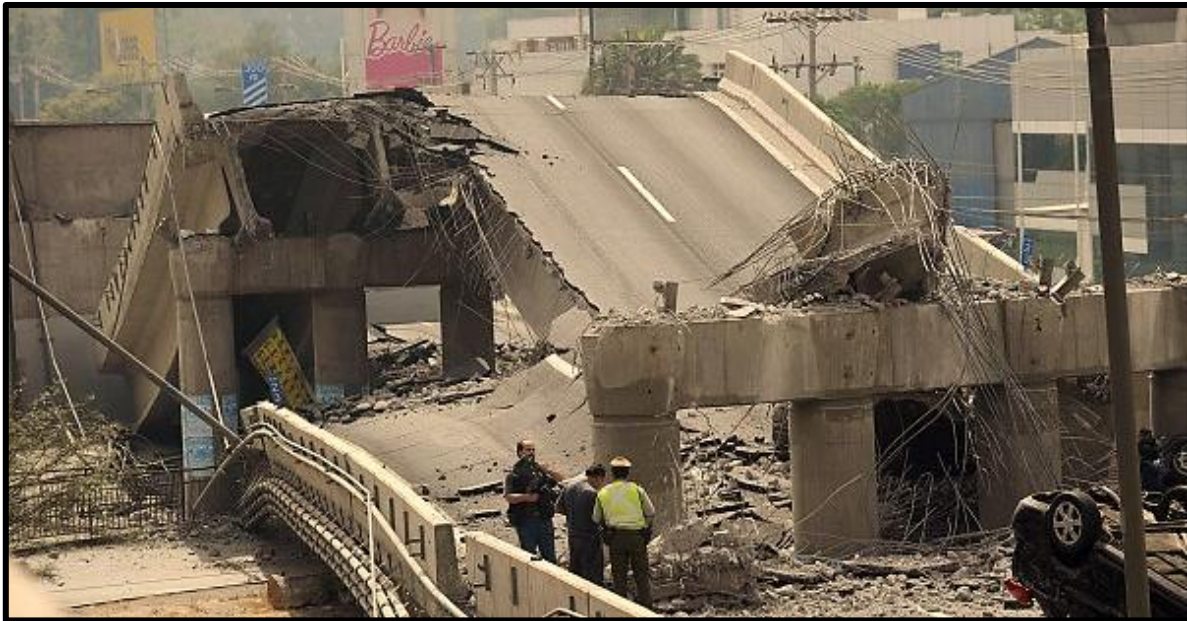
Figura 4.22.- Colapso del Paso a Desnivel debido a un sismo de magnitud de 8.8 grados Richter, Chile.
