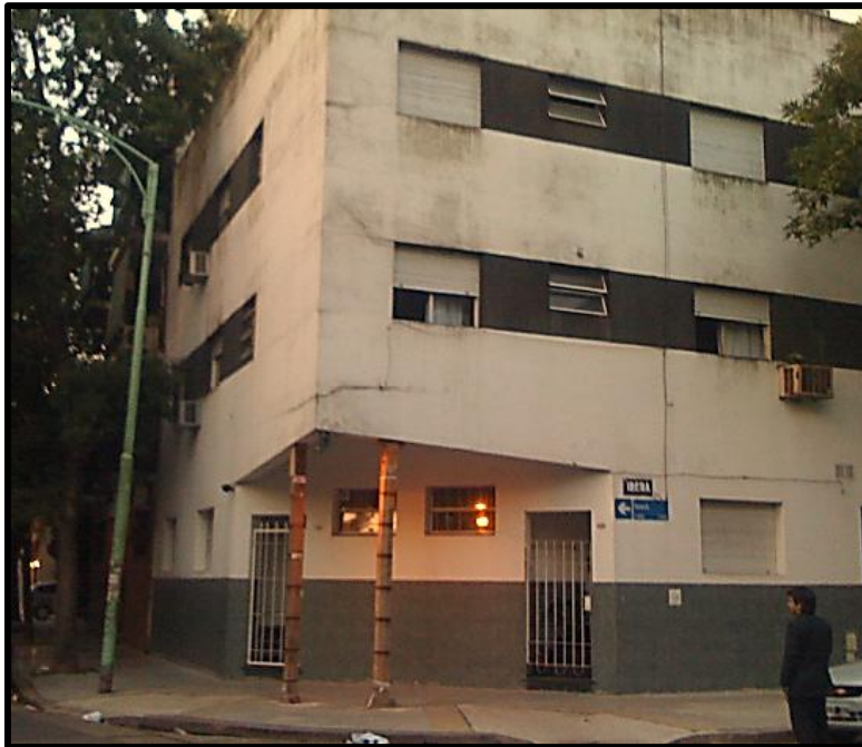
Figura 4.5.- Apuntalamiento por fisuras en edificio cercano al estadio del River Plate, Argentina.
