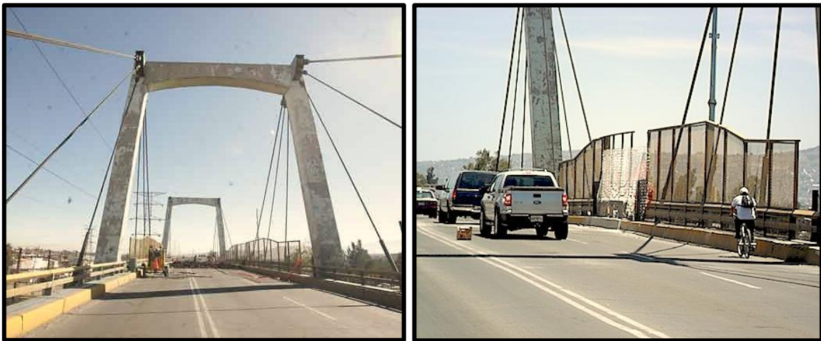
Figura 4.25.- Puente de República Federal, sobre Calzada Zaragoza, generación de vibraciones excesivas por el paso de vehículos, Distrito Federal.
