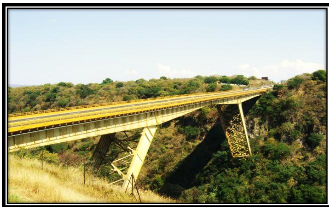
Figura 5.3.- Panorámica del puente Fernando Espinosa.
