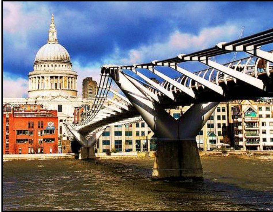
Figura 4.3.- La Pasarela Millennium Bridge de Londres experimento elevadas aceleraciones laterales el día de su inauguración el 10 de junio de 2000 por lo que fue reparada con la incorporación de numerosos amortiguadores.
