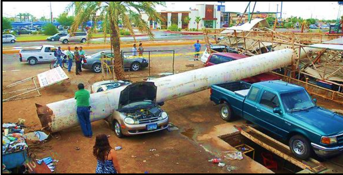
Figura 4.16.- Caída de un espectacular al paso de una tormenta, Mexicali Baja California.
