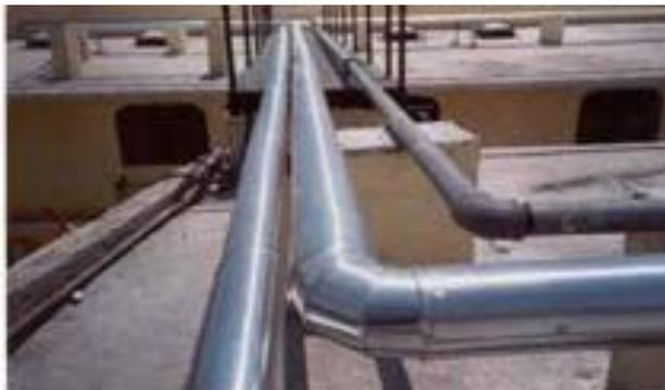
**Figura 41: Forros para tubería de agua helada tipo espejo.**
