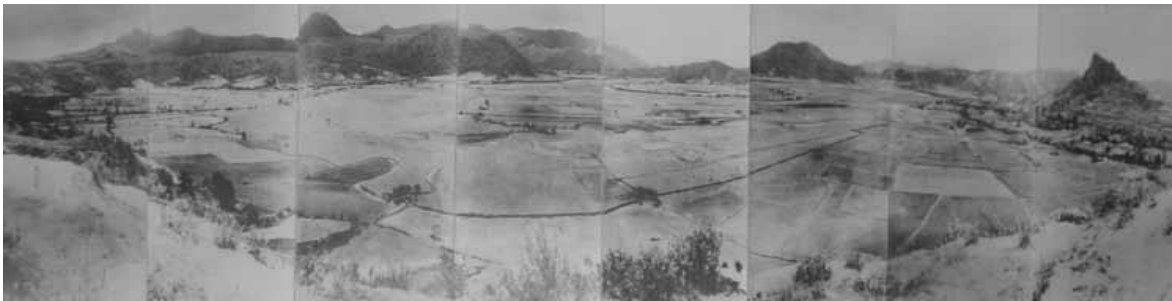
Figura 1. “El Plan” antes de la construcción de Ixtapantongo Valle de Bravo (Sierra et al. , 2011).
