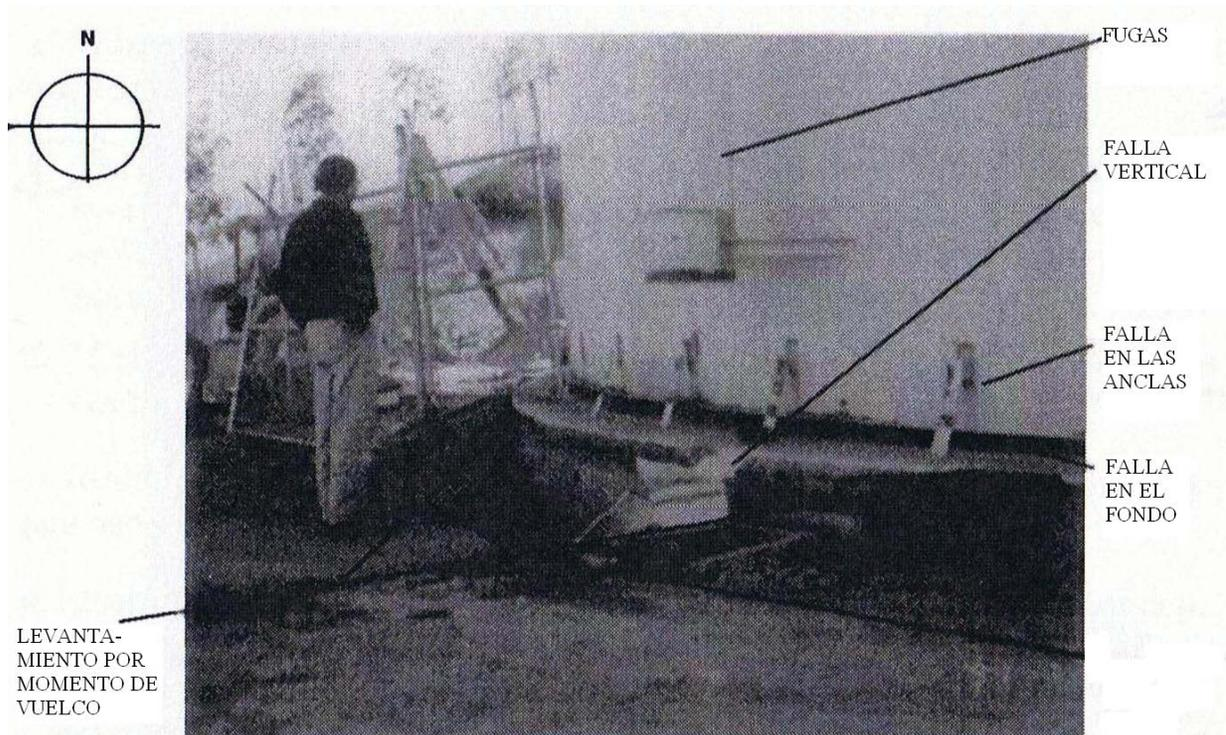
*Figura. 1.22 Daño en las anclas.*
