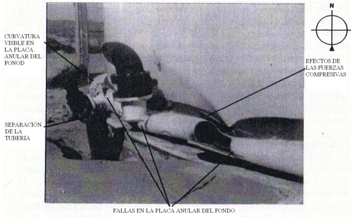
**Figura 1.23 Daño en la placa anular del fondo.**
