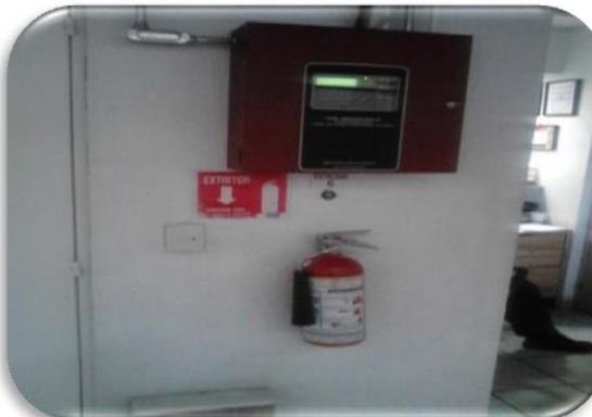
Fig. 9. Estación manual de emergencia y su señalamiento
