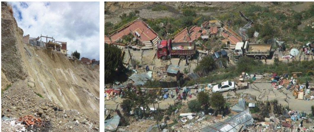
Imágene del internet, sobre el deslizamiento y el colapso del Colegio privado Leonardo da Vinci, hachayhuasi y el trabajo de salvataje de las volquetes del GAML. A la izquierda el lugar del deslizamiento mayor, foto del autor.
