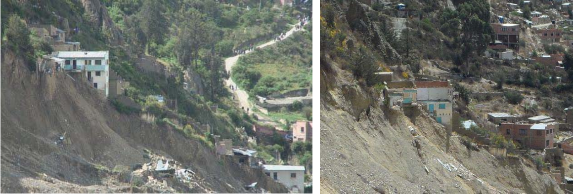
Dos fotos al parecer del mismo lugar, al principio y al medio del deslizamiento, vemos la casa amenazada y la casa ya parcialmente caída, fotos del internet.
