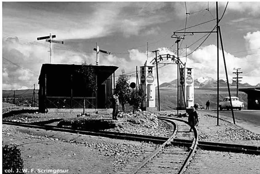
Imagen 26, Garita de ingreso a la ciudad hasta los años 50, (02) El Alto, al borde de la meseta, a una altura de 4.082 m. Aquí la parte electrificada del FCG (como la compañía ferroviaria abreviaba su nombre), comenzaba su descenso hacia La Paz en el valle [ver mapa]. [Co
