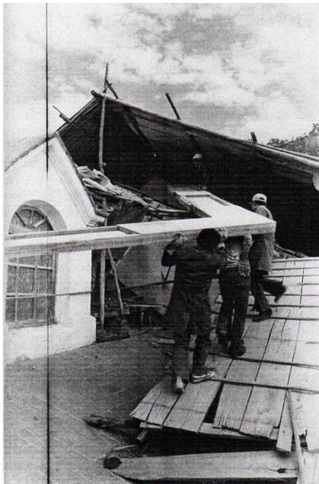
Imagen 43: Introducción de la nueva estructura de la cubierta del presbiterio. Tomada de: *El convento de San Diego de Quito*
