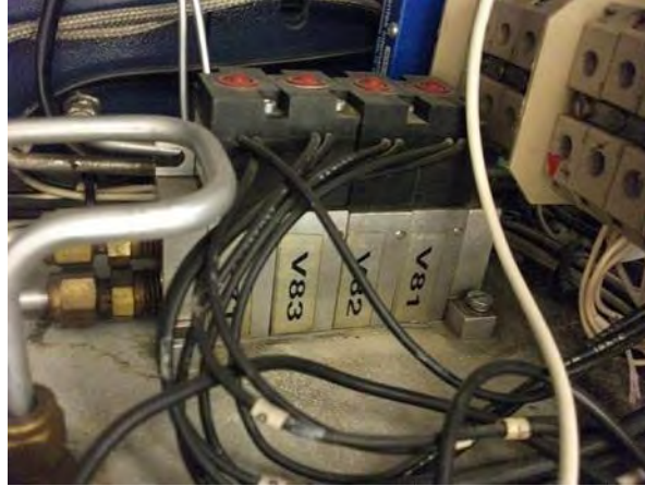
Figura 2. 9 Válvulas solenoides de enfriamiento (Fuente: Propia)
