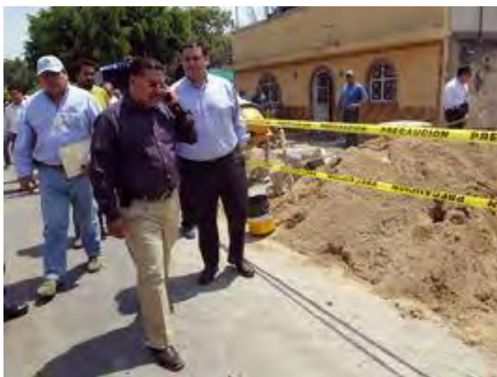
Director del organismo operador del agua SIAPA y el Presidente Municipal de Zapopan, visitando las casas destruidas por la rotura de la tubería en la colonia Balcones de la Cantera, Periódico El Mural Mayo 2011,
