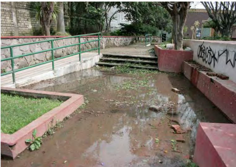
Fuga de agua en el parque la Alameda en la ciudad de Guadalajara, el SIAPA se desentiende. Periódico Monitor, julio 2010.
