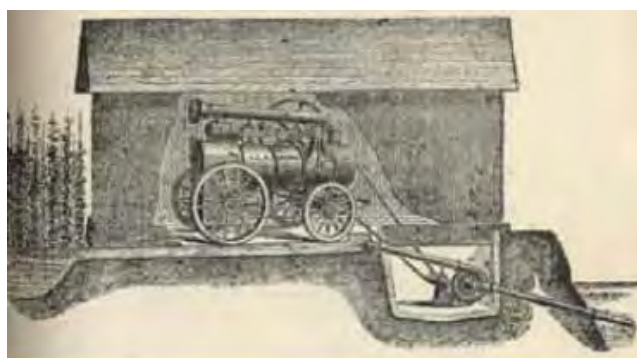
Primeras bombas de combustión
