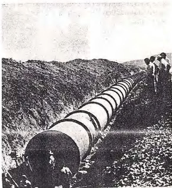
Vista de conjunto que muestra los tramos de tubería del acueducto, antes de ser rellenados.
