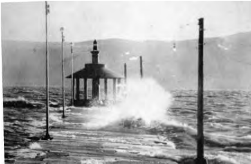
Vista muelle en 1935 en uno de sus máximos niveles
