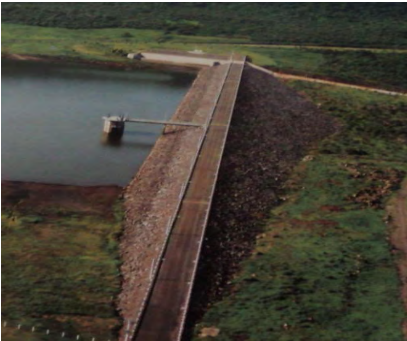
Vista aérea de la cortina de la presa Calderón.
