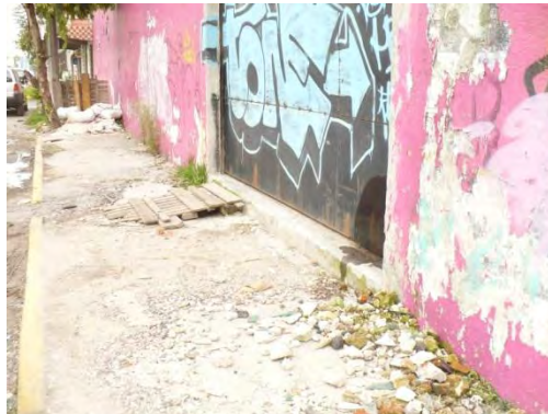
Vista acceso fábrica 1
