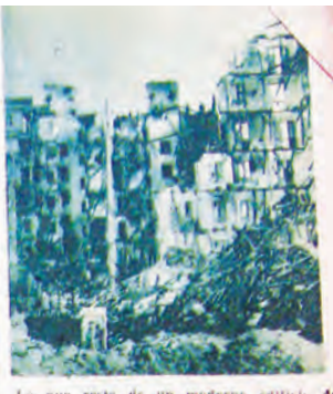
Lo que resta de un moderno edificio de apartamentos en Madrid.
