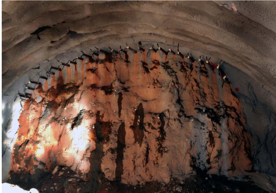
Sistemas de estabilización. Paraguas de anclas. (Marchabantes).
