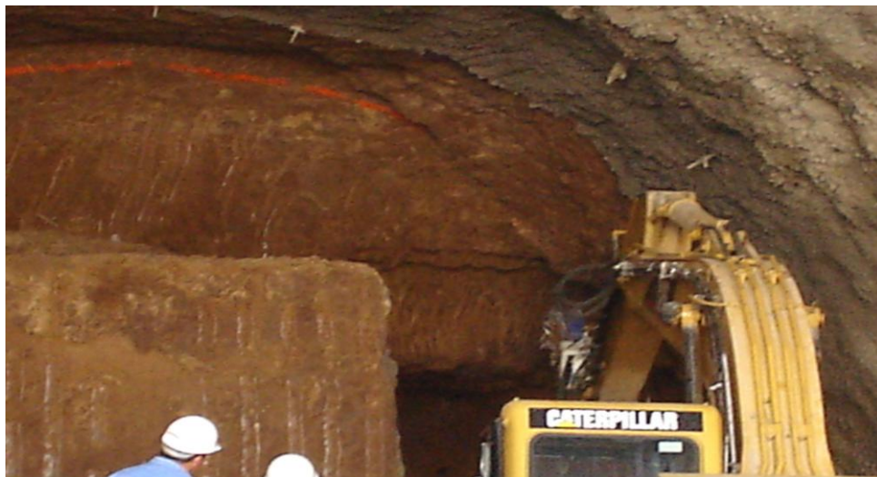
Uso del concreto lanzado y aplicado directamente sobre el terreno.
