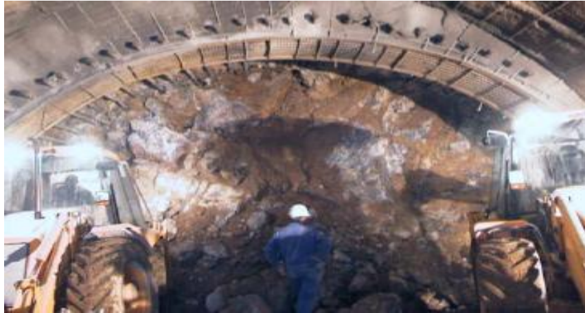
Sistema de paraguas a base de tubería.
