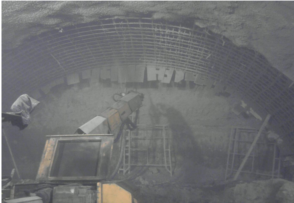
Uso del concreto lanzado y acero de refuerzo.
