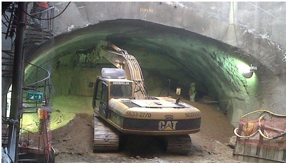
Excavación del frente mediante el uso de rozadora hidráulica.
