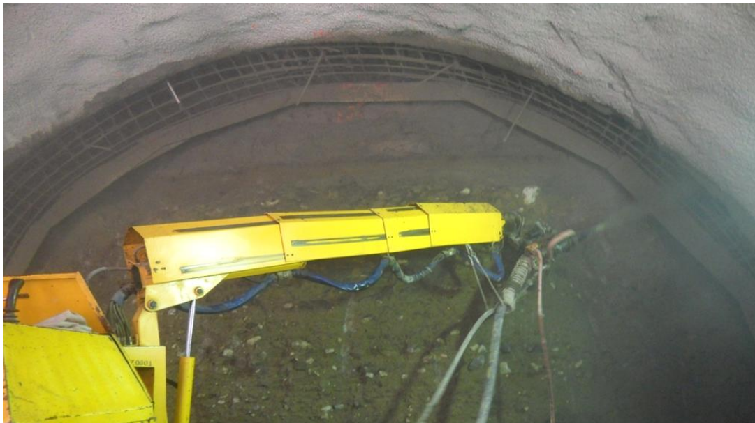
Uso del concreto lanzado sobre las paredes del túnel para estabilizar el terreno.
