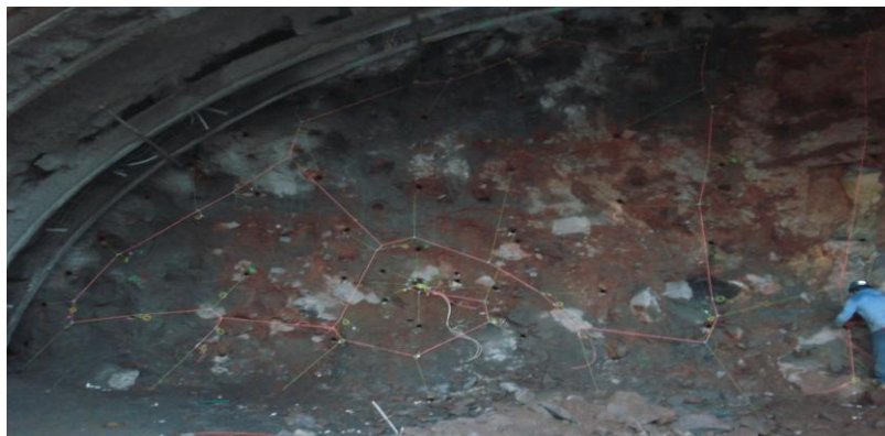
Excavación del terreno mediante voladuras.
