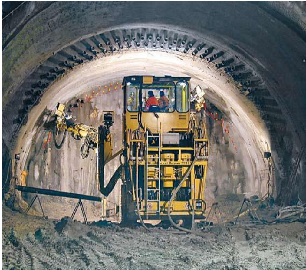
Sistema de paraguas a base tubería para fortificar el terreno durante la excavación.
