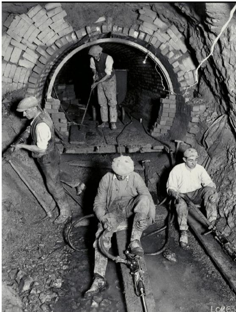
Uso de martillos neumáticos para excavación.
