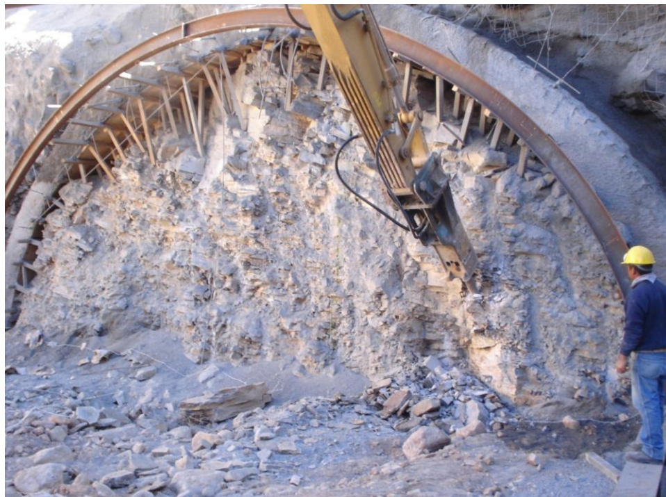
Uso de martillo hidráulico.
