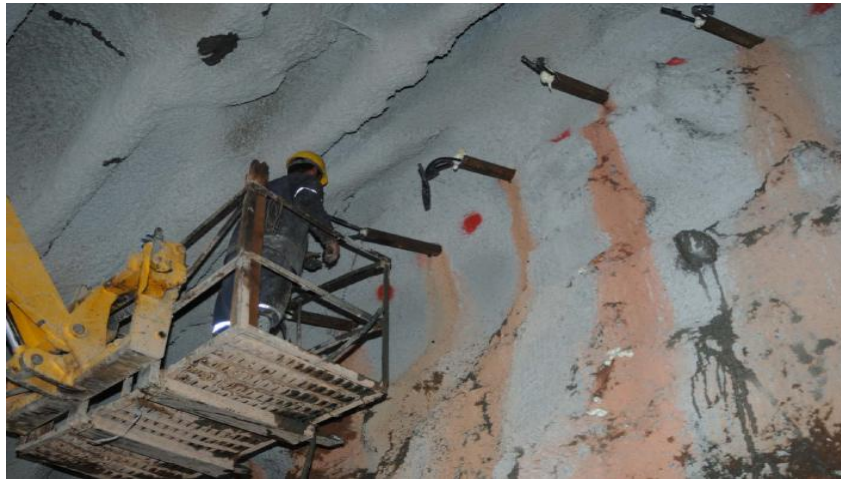
Inyección del paraguas.
