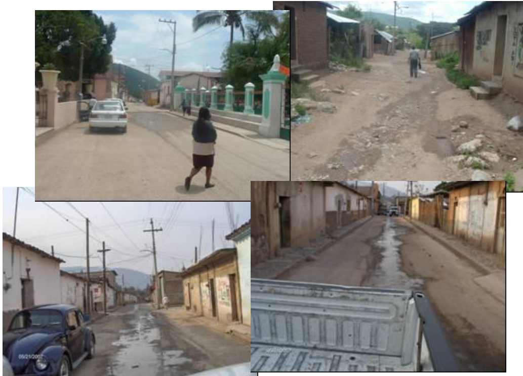
Descargas de aguas residuales hacia la calle.
