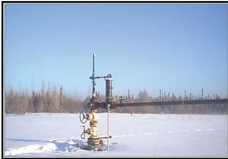
Figura 1.39 Embolo viajero instalado en Canadá
