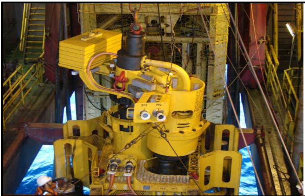
Figura 4.36 Instalación del módulo de bombeo
