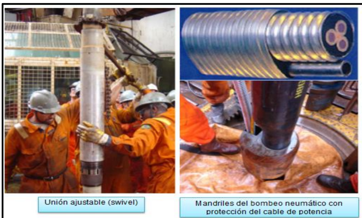
Figura 4.38 Unión ajustable, mandriles del bombeo neumático, y cables con protección
