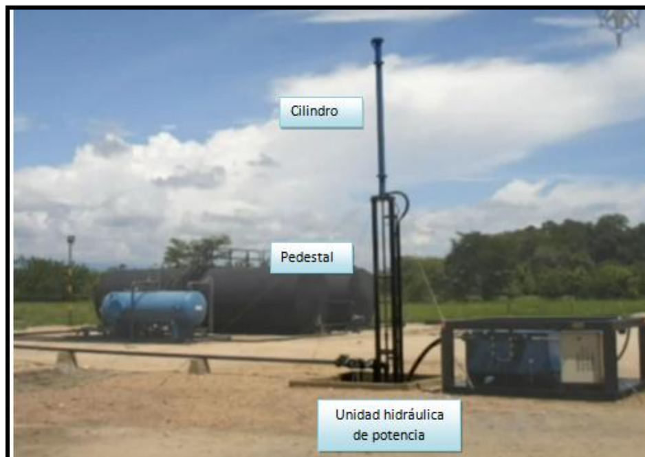
Figura 1.26 Unidad Hidroneumática TIEBEN
