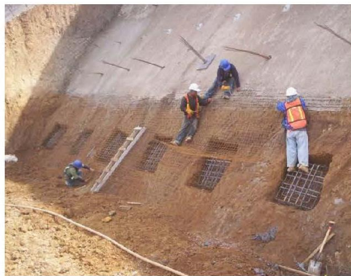
d) Colocación de zapatas de reacción
