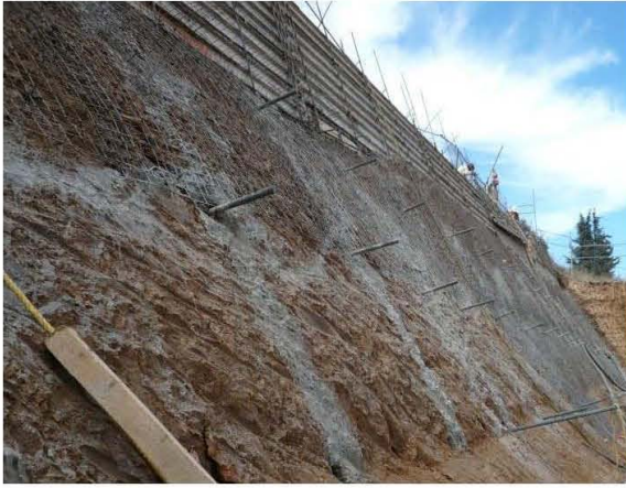
g) y h) Configuración del talud y construcción de anclas pasivas para refuerzo del suelo redepositado
