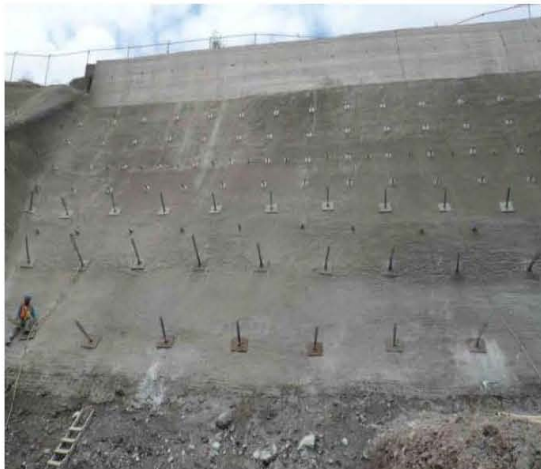
w) y x) Panorámica del corte reforzado
