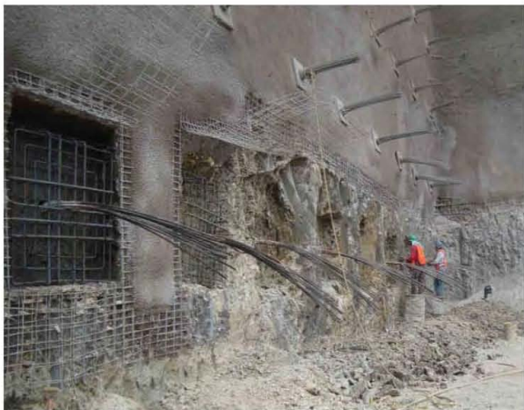
q) y r) Construcción de anclas en el estrato de roca volcánica
