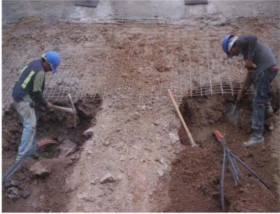
m) y n) Construcción de zapatas de reacción
