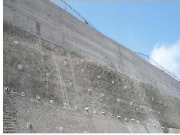
g) y h) Configuración del talud y construcción de anclas pasivas para refuerzo del suelo redepositado
