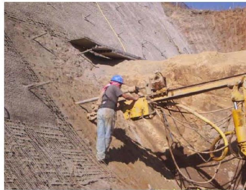
b) Perforación con equipo Track-Drill
