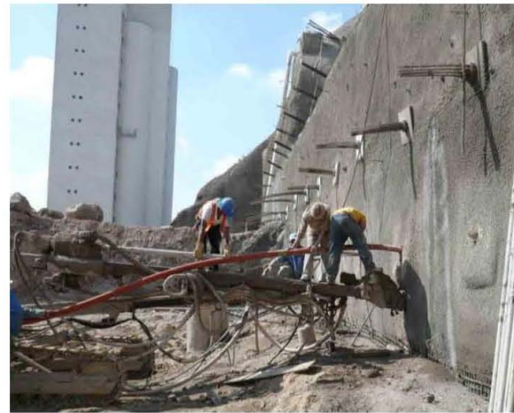
k) y l) Colocación de malla electrosoldada y habilitación de anclas postensadas
