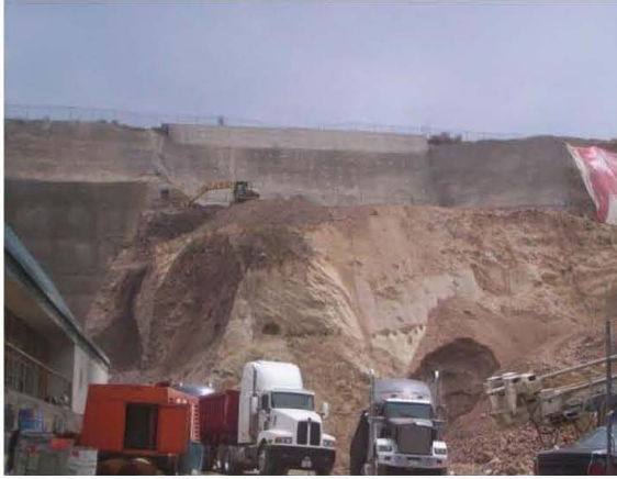
s) y t) Panorámica del muro de retención y clavos de anclaje
