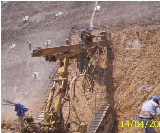
e) y f) Perforación y detalle de anclas pasivas
