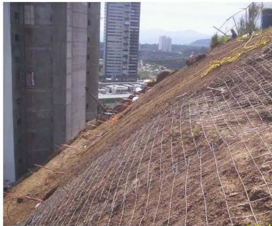
k) y l) Colocación de malla electrosoldada y habilitación de anclas postensadas
