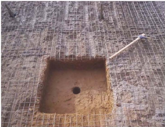
o) y p) Labrado y colado de zapata de reacción
