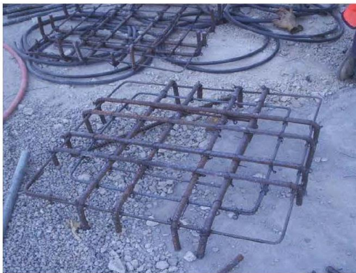
c) Habilitado de zapata de reacción
