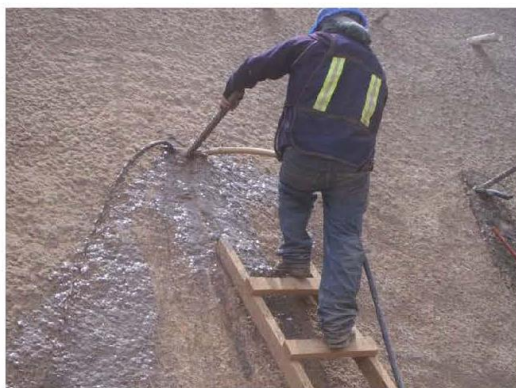
e) Inyección del ancla con lechada agua-cemento
