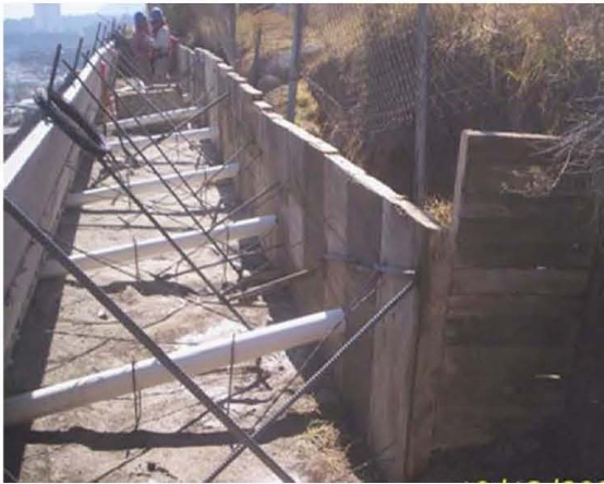
c) y d) Cimbrado y colado del muro de contención de mortero fluido
