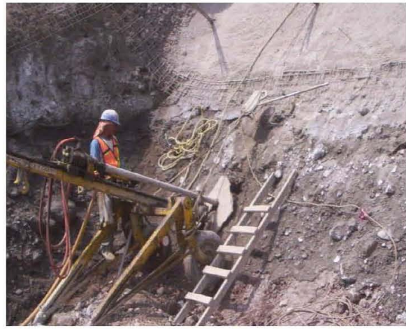
g) y h) Configuración del talud y construcción de anclas pasivas para refuerzo del suelo redepositado
