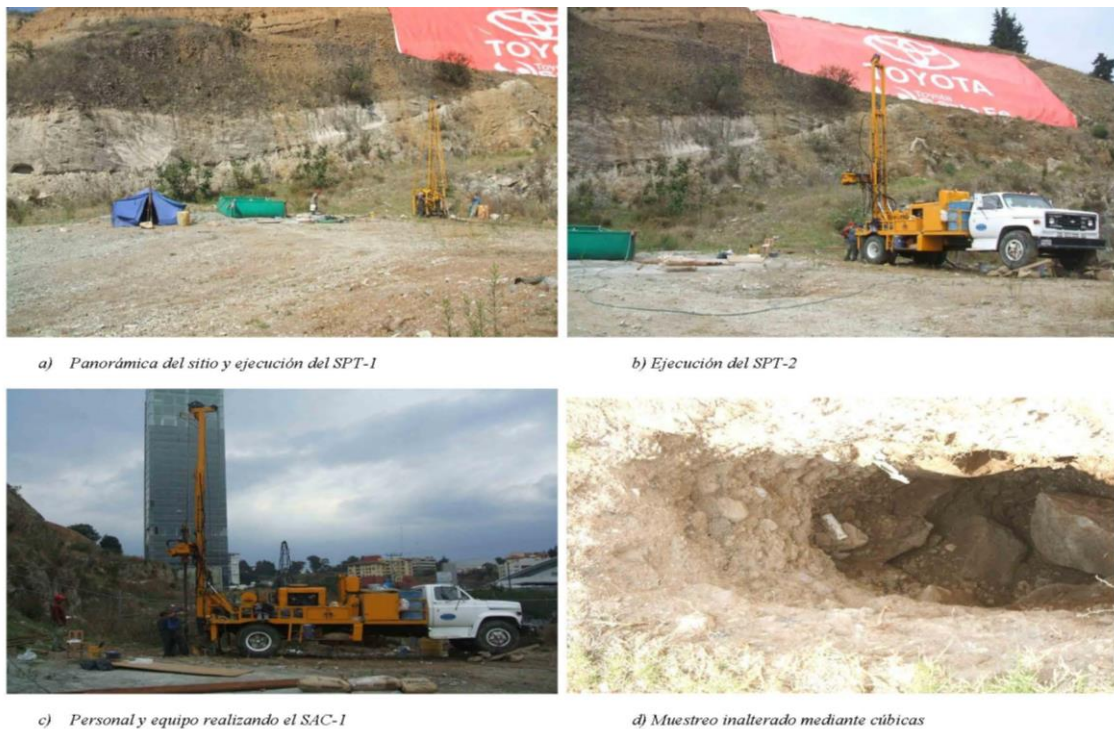
Fig. 2.3 Personal y equipo ejecutando los sondeos exploratorios
