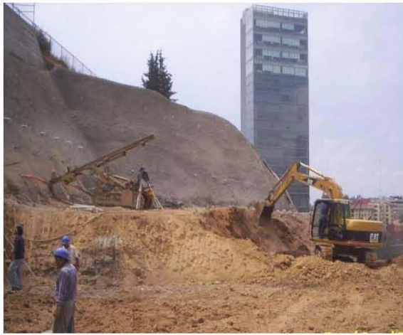
i) y j) Perforación para anclas postensadas
