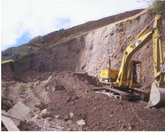
a) y b) Conformación de vialidades para acceso de equipo
