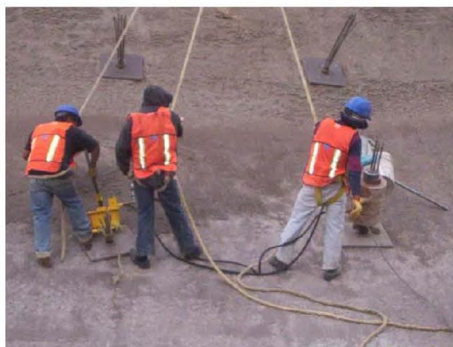
f) Tensado de ancla
