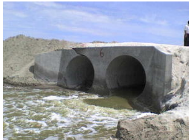
Fig. 3.-Ejemplo de alcantarilla de forma tubular
