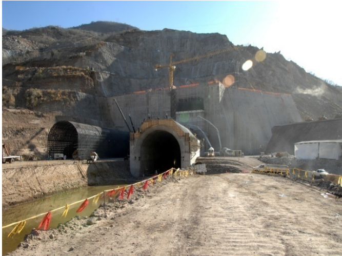
Fig. 2.-Ejemplo de túnel.
