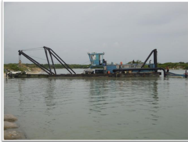
Fig.5. Dragado en la dársena del Puerto de Abrigo de Sisal
