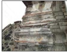
5. Una parte de las molduras de las portadas, o su continuación sobre el alféz-tablero que las integra al muro están fabricadas en ladrillo forjado y recubierto, y la degradación propia y de su recubrimiento de argamasa es notoria.
