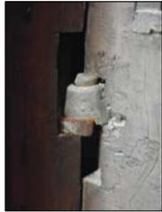
Los apoyos de abatimiento de las portillas no presentan un desgaste considerable, sin embargo estas deberán ser retiradas para permitir el desmonte básico de los elementos, una vez en taller, serán ajustadas para su perfecto funcionamiento, se propone rectificar el rodamiento mediante la inserción de un buje compuesto de un material metálico que lubrique integralmente, como es el caso del babyt.
