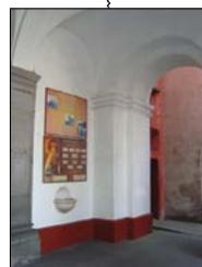
SUPERFICIE DE MUROS Y BÓVEDAS AFECTADAS POR RESANES A BASE DE CEMENTO Y APLICACIÓN DE PINTURA VINÍLICA, ADEMÁS DE LA PRESENCIA DE ELEMENTOS AJENOS COMO TAQUETES Y CABLES; LA PILA DE AGUA SOLO PRESENTA SUCIEDAD.
