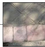
Placa reemplazada con mortero en sitio, a base de cemento blanco ocasionada con carbona.
