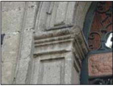
1. Daños accidentales y despostillamientos severos sobre los perfiles de cantera que componen los capiteles de las pilastras de ambas portadas
