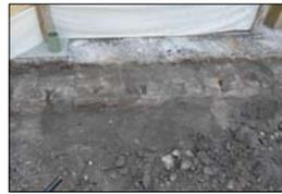
Al retirar una capa de relleno de escombros en el cual se detecto solo materiales antiguos de demolición, se descubrieron esta serie de peraltes, ya parcialmente despojados de su recubrimiento de cantera rosa.
