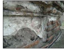
6. Todos los aplanados antiguos de argamasa han perdido su cohesión y se desintegran gradualmente exponiendo en gran parte el núcleo de mampostería que se usó para fabricar los remates y algunos elementos de las portadas.
