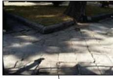
Groses agrietamientos ocasionados por empuje de los rebos contrahce.
