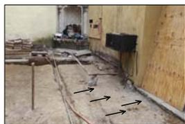
Imagen que muestra la banqueta fabricada con piedra de río asentada con tepetate, tierra y cal.
