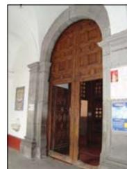
PORTÓN DE MADERA ENTABLERADO QUE PRESENTA ATAQUES DE JELFAGROS (POLILLA) AJUSTAMIENTO PROPICIADO POR EL DETERIORO DE LA CAPA PROTECTORA DE BARNIZ Y PERDIDA TOTAL DE ELEMENTOS POR DESGASTE MECÁNICO. EL SISTEMA DE AJUSTAMIENTO ESTÁ ESTRUCTURALMENTE VENCIDO, SUS ELEMENTOS DE HIERRO PRESENTAN DESGASTE Y CORROSIÓN.
