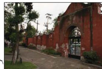
Vista general de la cara interna del paramento poniente (00), es visible en la imagen los problemas creados por humedades ascendentes y descendientes en puntos muy específicos del muro y que delatan un descuido de años.
