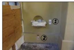
Imagen que muestra claramente las dos exploraciones (Clasificadas como 1 y 2) realizadas sobre este paramento.
