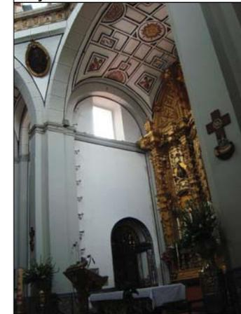
Es curiosa la calidad y cantidad de relieves conseguidos mediante la colocación de ladrillo y tejon de barro cocido y su modelado.
