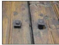
Herrajes mal colocados u ocasionando daño por penetración en las superficies de madera.
