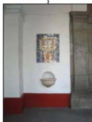
SUPERFICIE DE MUROS Y BÓVEDAS AFECTADAS POR RESANES A BASE DE CEMENTO, APLICACIÓN DE PINTURA VINÍLICA, ADEMÁS DE LA PRESENCIA DE ELEMENTOS AJENOS COMO TAQUETES Y CABLES; LA PILA DE AGUA Y EL MURAL DE AZULEJO SOLO PRESENTAN SUCIEDAD.
