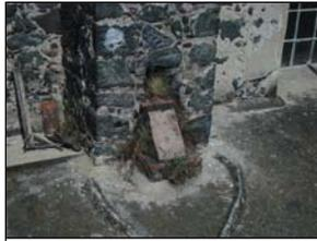
Sistema de desague pluvial que corre dentro de uno de los contrafuertes invadido de flora debido a la negligente atención, la mampostería desnuda sufre los efectos del prolongado intemperismo.
