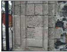
4. Es notorio que en otros tiempos se hicieron reposiciones de algunos elementos de piedra, sin embargo no se cuidó la coincidencia del material usado, aquí piezas de pilastras.
