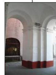
SUPERFICIE DE MUROS, ARCOS Y BÓVEDAS AFECTADA POR RESANES A BASE DE CEMENTO Y APLICACIÓN DE PINTURA VINÍLICA, ADEMÁS DE LA PRESENCIA DE ELEMENTOS AJENOS COMO TAQUETES Y CABLES; DAÑO POR INTERVENCIÓN CON EL APLICADO DE UN GUARDA POLVO FABRICADO CON MEZCLA DE CEMENTO QUE PRESENTAN EN TODO SU CONTORNO TANTO MUROS COMO PILASTRAS.
