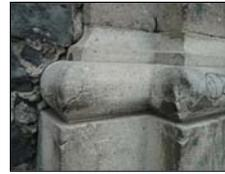
7. Las reposiciones o injertos de cantera practicados en la década de 1970 muestran un grave deterioro y desintegración, demostrando ser una selección de tipo de piedra inadecuada.
