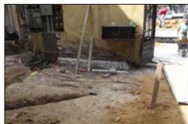
En la imagen se aprecia el trabajo de consolidación efectuado sobre la banqueta de cimentación, dicho trabajo consistió en la reintegración de piezas sueltas y el juntas con argamasa de cal-arena.
