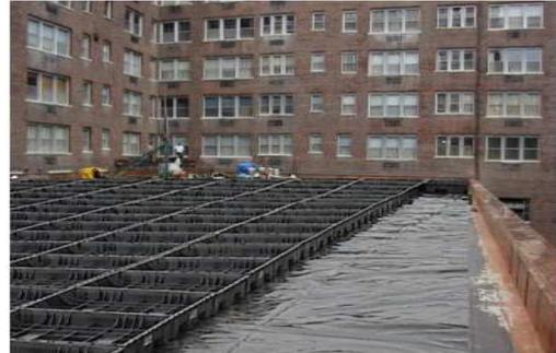
Imagen 34 Módulos de polietileno reciclado
