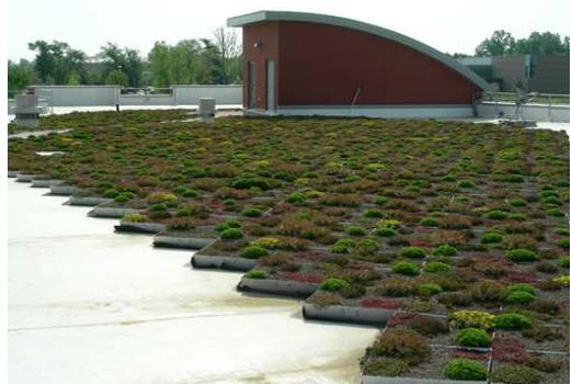
Imagen 31 Módulos Green Roof Blocks en azotea
