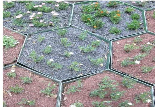
Imagen 45 Módulos hexagonales de polipropileno
