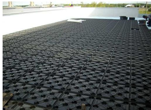
Imagen 37 Módulos de polietileno reciclado
