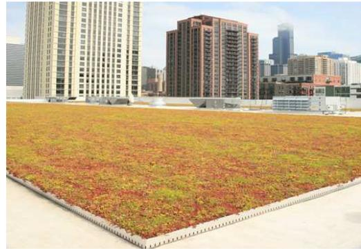
Imagen 39 Módulos Live Roof en azotea
