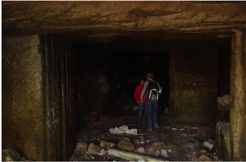
Figura 1.2. Interior de una mina en Atizapán de Zaragoza
