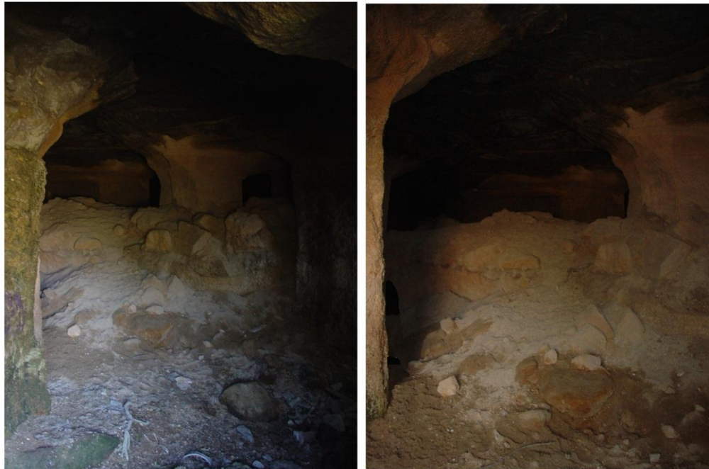
Figura 1.23. Bloques caídos y desintegración de materiales constituyentes de minas en Atizapán de Zaragoza
