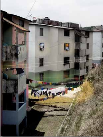
Figura 15. Conjunto de viviendas, la insuficiencia de espacios para los servicios son extendidos por los usuarios, Unidad Habitacional Nuevo Xalapa, 2010. Fuente: (imagen del autor)
