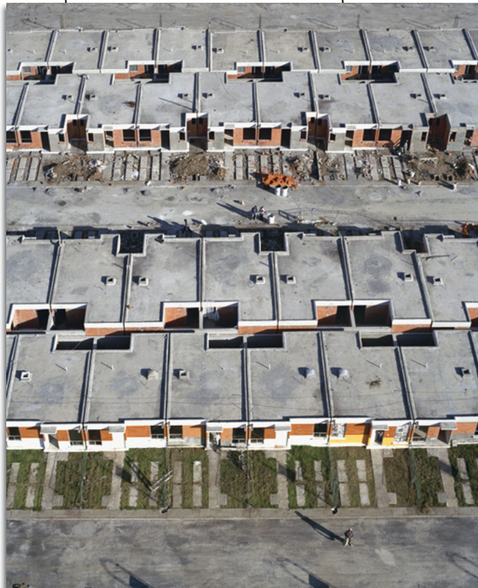
Figura 20. Vista aérea de azoteas donde se aprecia la repetición y áreas mínimas que separan a las viviendas de interés social, (Fuente: Colección two Million homes for México, http://www.liviacorona.com )
