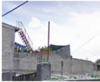
FOTO CALLE ALDAMA <AZOTEAS>
