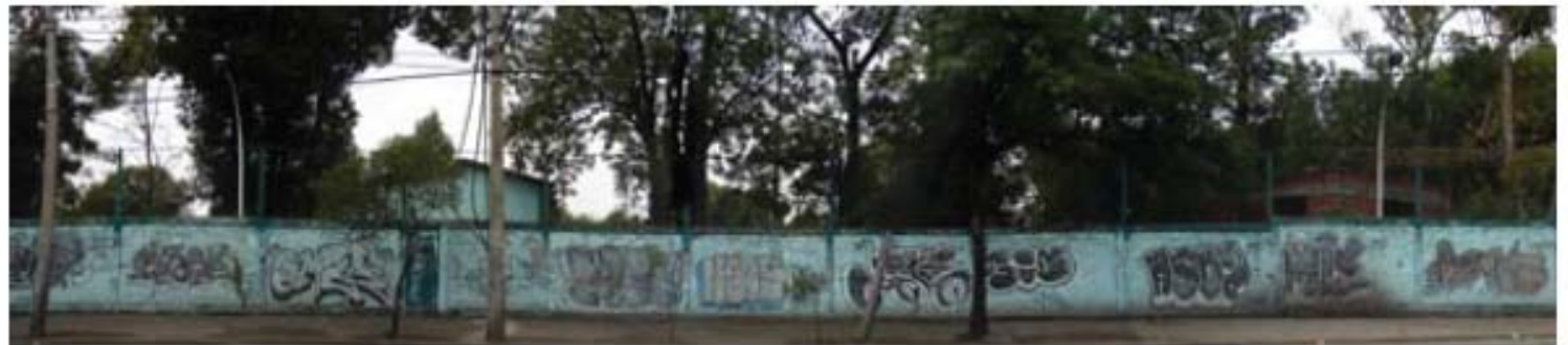
FACHADA EX REFINERIA 18 DE MARZO
