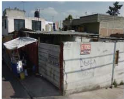
FOTO CALLE ALDAMA <AZOTEAS>
