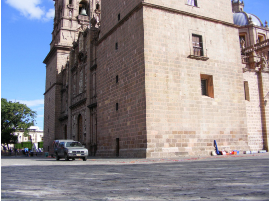
Fotografía 5 Vista de la esquina NW de la catedral de Morelia
