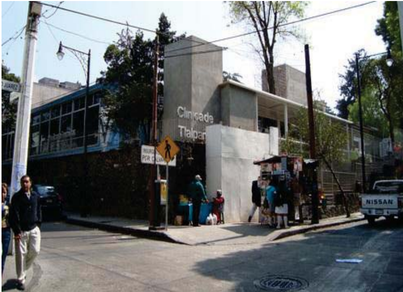
FACHADA SURESTE-ANTES DE LA REMODELACIÓN
