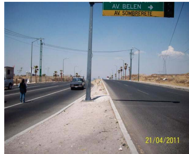
2. IMG. IZ. VISTA BLVD. DE LA NACIÓN HACIA LA AV. 5 DE FEBRERO EN EL PONIENTE.
