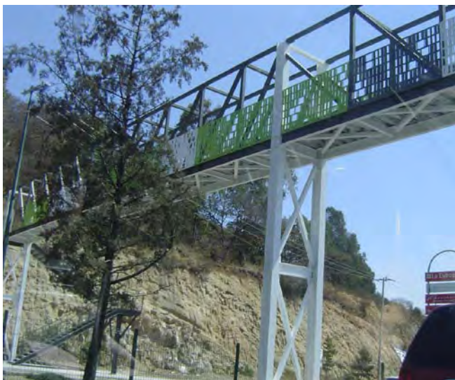
Imagen 3.11 Puente peatonal intersección con Av. Residencial Chiluca
