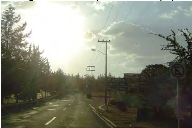
Imagen 3.73 Salida a paso a desnivel (E1)
