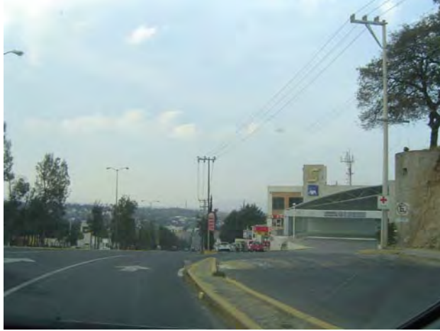
Imagen 3.43 Acceso vehicular a carriles laterales de la zona comercial (B1)
