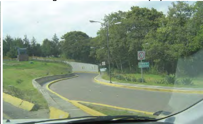
Imagen 3.74 Paso a desnivel (E2)
