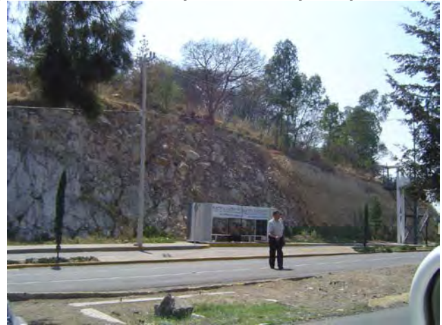
Imagen 3.36 Caseta de espera de transporte público (A4)
