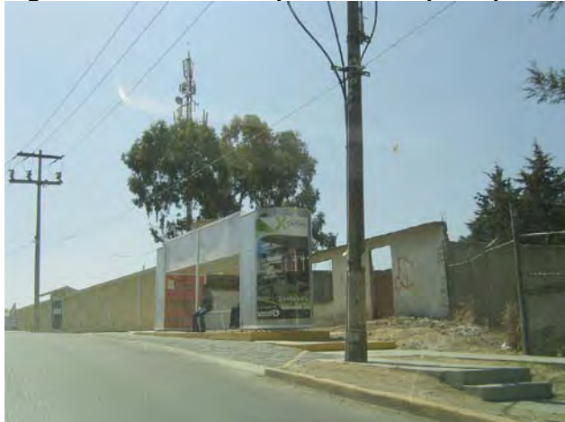
Imagen 3.37 Caseta de espera de transporte público (A5)
