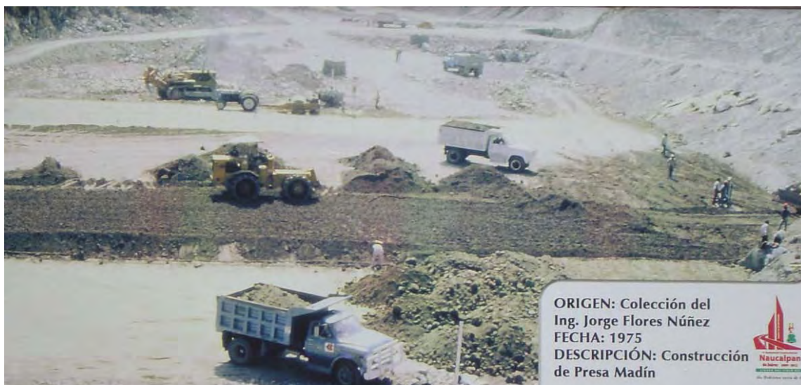
Imagen 1.16 Construcción de la Presa Madín 1975.
