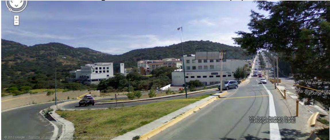
Imagen 3.52 Paso a desnivel vehicular (C3)
