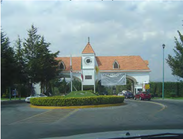
Imagen 3.87 Pórtico de acceso a Condado de Sayavedra (F5)
