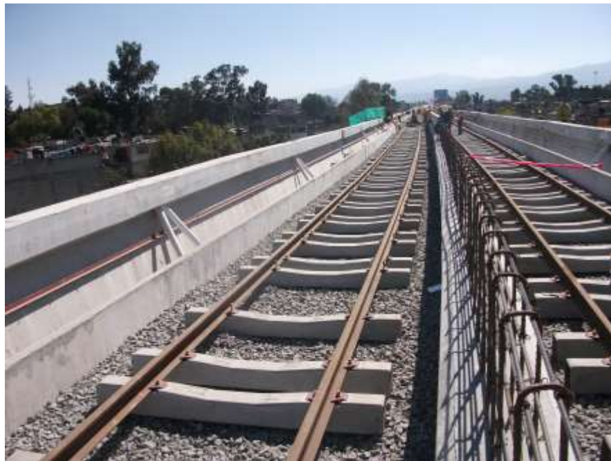
Ubicación de vía.
