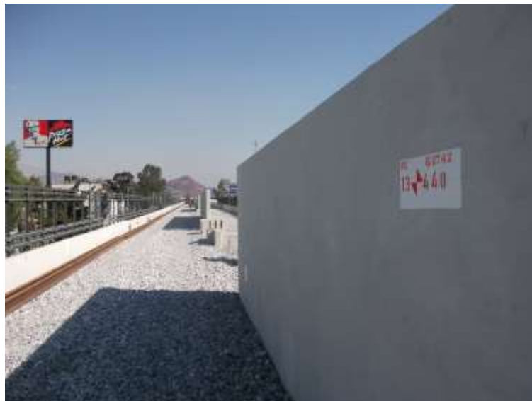
Marcas para la colocación de vía.
