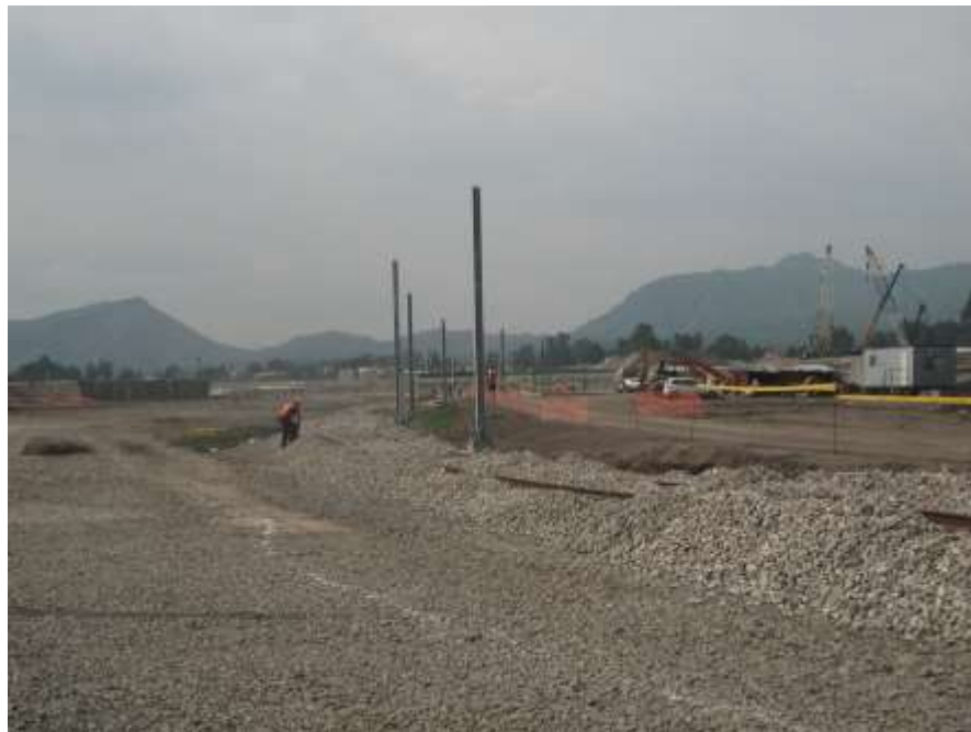
Esparcimiento de balasto.
