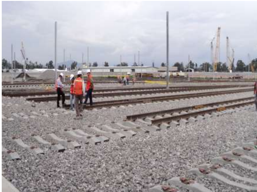
Armado de vía.
