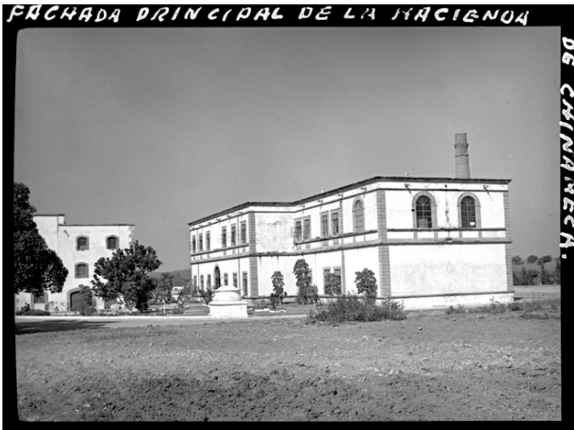
Fig. 6. Fachada principal de la hacienda de Chinameca
