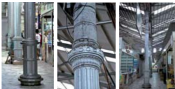
Figs. 330, 331 y 332. Mercado Pino Suárez de Mazatlán. Fundición de Sinaloa , 1896. Detalle de las columnas . Foto: RV, 2011
