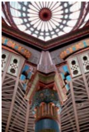
Figs. 215 y 216. Detalles del quiosco morisco, antiguo pabellón para la exposición de Nueva Orleans Arq. Ing. José Ramón Ibarrola, 1884. Foto: RV, 2006
