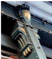
Figs. 439 y 440. El antiguo almacén La Ciudad de México , Puebla, 1910. Detalle de las pilastras de la fachada, con el sello de la fundición Schwartz et Meurer de París. Foto: RV, 2006
