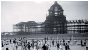
Fig. 1001. Una vista del armazón metálico del Palacio Legislativo Foto Casasola, en: www.ngenespanol.com
