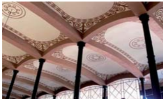
Figs. 259 y 260. Mercado González Ortega, Zacatecas, Ing. C. Suárez Fiallo, 1886-1889 Dos vistas interiores del mercado actual, en las que se pueden apreciar las bóvedas del sistema Gustavino. Foto: RV, 2008
