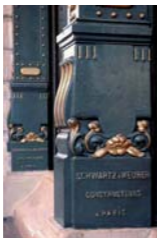
Figs. 439 y 440. El antiguo almacén La Ciudad de México , Puebla, 1910. Detalle de las pilastras de la fachada, con el sello de la fundición Schwartz et Meurer de París. Foto: RV, 2006
