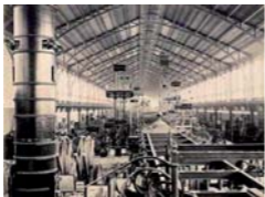
Fig. 156. La Galerie des Machines, ing. Henri Dion, vista interior www.verdeau.com
