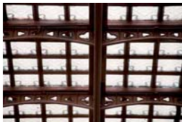
Figs. 235 y 236. El Teatro Juárez, Guanajuato, 1873-1903. El techo de acero y loza de cristal del vestíbulo. Foto: RV, 2008
