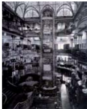
Fig. 268. El Centro Mercantil , México, 1899 ing. Gonzalo Garita, Ing. D. Garza, arq. P. Dubois Foto: colección Bernard Martel
