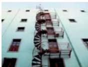
Figs. 230 y 231. El Teatro Juárez, Gto, 1873-1903. La escalera de emergencia, en la foto a la derecha se nota el detalle del sello de la fundición Marshall Brothers , de Pittsburgh. Foto: RV, 2008
