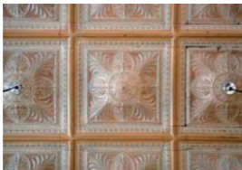
Fig. 696. Detalle de la lámina metálica estampada que recubre los techos de las salas del actual Museo de Geología Foto: RV, 2007
