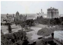
Figs. 291 y 292. Pabellón de Argentina para la Exposición de París de 1889, arq. Albert Ballú Dos imágenes del pabellón en su reubicación en la Plaza San Martín de Buenos Aires Foto: L'architettura del ferro. L'Argentina. 1850-1930 , de O.Jolita y R. Vassallo (arriba); www.mx.fotolog.com (abajo)
