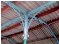
Figs. 581 y 582. La estación de Atlixco, Puebla; detalle de las ménsulas y de los capiteles que ornamentan la estructura de hierro que sostiene el techo de dos aguas del área de espera, revestido por lámina metálica. Foto: RV, 2008
