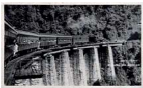
Fig. 137. El puente de Metlac donde los pilares ya estaban recubiertos de concreto, antes de 1940 Foto: Postal de la Cia Industrial Fotográfica, colección Bernard Martel
