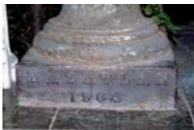
Figs. 946, 947 y 948. Hotel Los Portales, Álamos, Sonora, 1904 ca. Abajo, detalle del capitel y del sello de la Fundación de Mazatlán en la base de las columnas. Foto: RV, 2011
