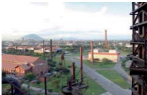
Fig. 603 Una vista panorámica del Parque Fundidora tomada desde arriba del Alto Horno núm. 3 Foto: RV, 2008
