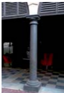
Figs. 952 y 953. Ex hacienda Aldama, El Fuerte de Montescclaros, Sinaloa, 1906 ca. Una columnas de hierro fundido con el detalle de la base que lleva el sello de la Fundición de Mazatlán Foto: RV, 2011
