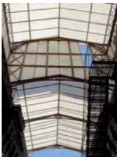
Figs. 697 y 698. La escalera de servicio del actual Museo de Geología, con el techo de hierro y vidrio que la abriga Foto: RV, 2008
