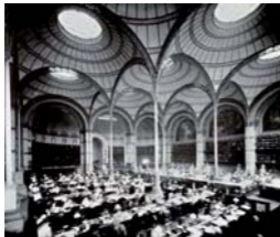
Fig. 104. La Biblioteca Nacional de París, arq. Henri Labrouste, 1868-1878 Foto: L'architettura del ferro in Francia , de Romano Jodice
