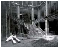
Figs. 489, 490 y 491. La Casa Boker, ciudad de México, 1898-1900, arqs. De Lemos y Cordes Fotografías del edificio en construcción, tomadas por Guillermo Kahlo sobre encargo de Roberto Boker. En el libro: Fridas Vater. Der Fotograf Guillermo Kahlo , de Gaby Franger y Rainer Huhle
