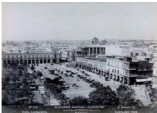
Fig. 495. El Centro Mercantil en construcción en la esquina suroeste del zócalo capitalino Foto: Alfred Saint-Ange Briquet, 1897 ca.
