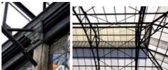
Figs. 349 y 350. El mercado 16 de Septiembre, o Centenario, hoy Cosmovital , Toluca, 1910. Detalle del enlace del armazón de acero con la pilastra revestida de cantera (izquierda), y del armazón metálico que sostiene la cubierta (derecha). Foto: RV, 2009
