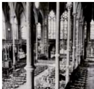
Fig. 89. Iglesia de Saint Eugène , arq. L.A. Boileau
