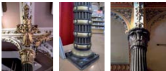
Figs. 478, 479 y 480. Joyería La Esmeralda, arqs. Eleuterio Méndez y Francisco Serrano, 1890-92 Detalle de las columnas de hierro fundido de la planta baja (izq. y centro), y del primer piso (der.) Foto: RV, 2008
