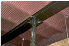
Fig. 643. La estructura interior del antiguo Hotel Bilbao, Tampico. Foto: RV, 2008
