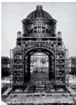
Figs. 998 y 999. Foto izquierda: una lámina del proyecto original del Palacio Legislativo, arq. Émile Bénard, 1904. En: Archivo de la Secretaría de Comunicaciones y Transportes Foto derecha: el armazón metálico de la cúpula central del Palacio Legislativo, foto Guillermo Kahlo, 1912, en el libro Frida's Vater
