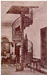
Fig. 64. La fotografía de una escalera de caracol en el catálogo de la Fundición de Sinaloa Foto: Artes de México , núm. 72
