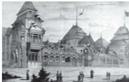
Fig. 201. Proyecto del Cuartel Mexicano para la Exposición de Nueva Orleans Arq. Ing. Ramón de Ibarrola, 1884. Foto: Arquitectura del siglo XIX en México , de Israel Katzman
