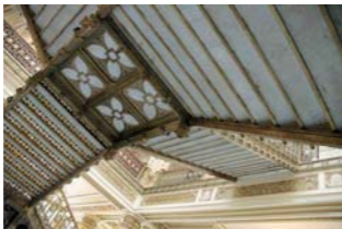
Fig. 679. La escalera metálica del Palacio Postal, arq. Adamo Boari, 1902-1907. Foto: RV, 2006
