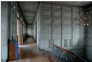
Fig. 770. Una imagen del espacio interior, cuyas paredes están enteramente revestidas por lámina metálica estampada, del antiguo Palacio Municipal de Orizaba, 1894. Foto: RV, 2007
