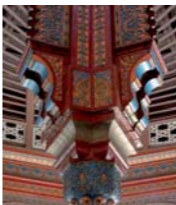
Fig. 207, 208 y 209. El antiguo pabellón mexicano para la Exposición de Nueva Orleans de 1884, hoy quiosco de Santa María la Ribera. Plano original del detalle constructivo de las columnas de hierro fundido, de la fundición Keystone Bridge Company (plano completo y detalle), en: AHDF, planoteca, caja 123, exp. 23. Foto: RV, 2012 (abajo derecha) El perfil de la columna del quiosco, que se realizó tal cual el plano del proyecto Foto: RV, 2006
