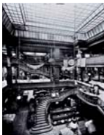
Fig. 449. Au Bon Marché , París, 1872-1874 arq. Louis C. Boileau, ing. Gustave Eiffel Foto: Estudio Chevojon
