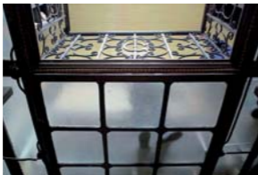
Figs. 708 y 709. El sistema celular para el resguardo de los libros en la biblioteca del actual Museo de Geología (arriba), y detalle de las losas de vidrio estructural (abajo). Foto: RV, 2008
