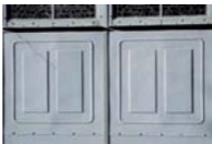
Figs. 749, 750, 751 y 752. La iglesia de Santa Bárbara, en Santa Rosalía, Baja California Sur, 1894. (arriba) Detalles de las armaduras de vigas de celosía (izq.) y de las ventanas ojivales (der.) Foto: Dante Busquets, 2012;(abajo) Detalle de las placas de lámina metálica ensambladas con remaches Foto: Dante Busquets (izq.), 2012; RV (der.), 2005
