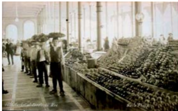
Fig. 258. Mercado González Ortega, Zacatecas, Ing. Carlos Suárez Fiallo, 1886-1889 Vista interior del mercado reconstruido; se notan las columnas más espaciadas que en la fotografía anterior y las bóvedas del sistema Guastavino Foto: Charles B. Waite, 1905, en: AGN, Fondo: Instrucción Pública y Bellas Artes; Serie: Propiedad artística y Literaria; Tema: Mercados; inv. núm. 66
