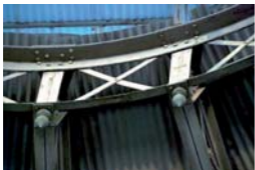
Figs. 180, 181 y 182. La antigua cubierta del circo Orrin, luego del Cine-Teatro Isabel de Tampico, hoy del patio para la subasta de ganado de un rancho en las afueras de Tampico. Detalles constructivos Foto: RV, 2008
