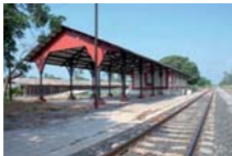
Figs. 579 y 580. La estación de Cuyutlán, Colima; vista general y detalle de los rieles utilizados como soportes verticales. Foto: RV, 2011
