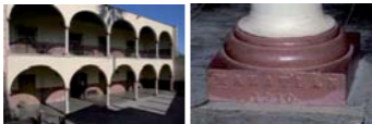
Figs. 949 y 950. Escuela Bartolomé M. Salido, Álamos, Sonora, 1910 ca. Vista del patio con las columnas de hierro fundido, y detalle de la base de una columna, con el sello de la Fundación de Mazatlán . Foto: RV, 2011
