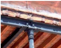
Figs. 940, 941, 942, 943 y 944. Hacienda de Tacoaleche, Refugio Reyes, Zacatecas, 1891-1895. Fachada, patio principal y detalle de la junta de las columnas con los rieles del techo Foto: RV, 2008
