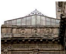
Figs. 369 y 370. El Pasaje La Mexicana, arq. Genaro Alcorta, 1905-1906. Acceso del callejón 5 de Mayo. Foto: RV, 2012
