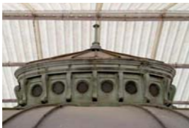
Figs. 702, 703 y 704. El tragaluz que ilumina el hall de ingreso al actual Museo de Geología. Una vista desde abajo, con el barandal de la escalera en primer plano (arriba), y dos imágenes del cuerpo del tragaluz tomadas en la azotea del edificio. Foto: RV, 2008
