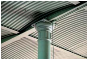
Fig. 593. La estación del Ferrocarril Central Mexicano en Aguascalientes, arq. Kenneth M. Murchison, 1911 Foto: RV, 2008
