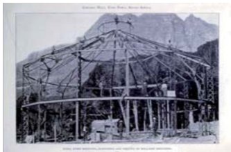
Fig. 66. Una lámina del catálogo de Milliken Bros. New York de 1905, con una fotografía del armado de una sala de concierto para Sudáfrica
