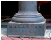
Figs. 952 y 953. Ex hacienda Aldama, El Fuerte de Montescclaros, Sinaloa, 1906 ca. Una columnas de hierro fundido con el detalle de la base que lleva el sello de la Fundición de Mazatlán Foto: RV, 2011
