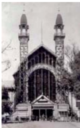
Fig. 6. El antiguo pabellón de exposiciones en el ciudad de México, actualmente Museo Universitario del Chopo, 1903-1905, diseño: Paul Knobbe, director de obra: ing. Luis Bacmeister, ing. Aurelio Ruelas, arq. Hugo Dörner. Foto: Colección Bernard Martel
