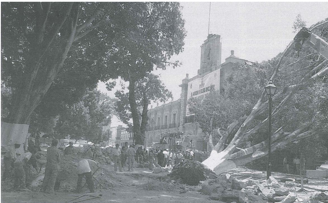
Anexo 13. Fotografía del castaño de la India que fue derribado durante los trabajos de remodelación del Zócalo de la Ciudad. En la foto se puede ver cómo cayó encima de Palacio de Gobierno.
