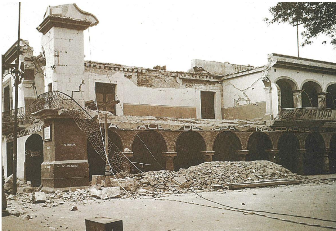
Anexo 2. Imágenes de los derrumbes causados por el terremoto de 1931 en la Ciudad de Oaxaca.
