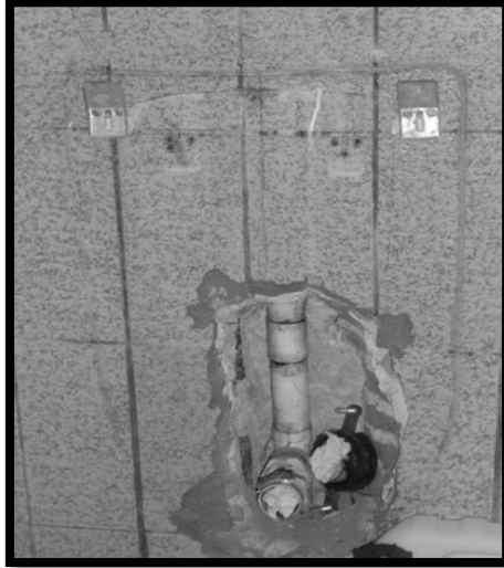
Figura 22 Desinstalación de Mingitorios
