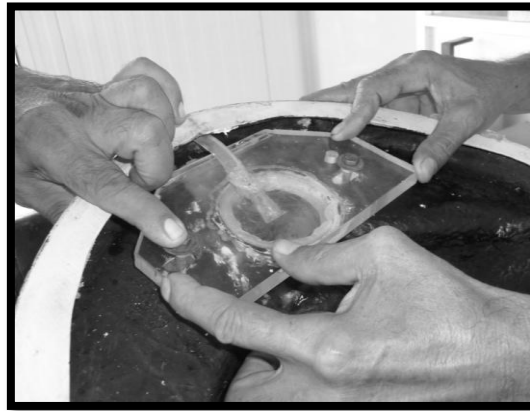
Figura 23 Detalle de adaptación de tapón de acrílico y manguera
