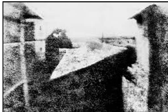
Vista desde la ventana de Gras 41 , La primera fotografía, Nicéphore Niépce, 1826.
