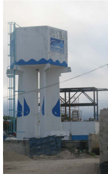
Figura 33: Tanque de agua de Sabancuy
