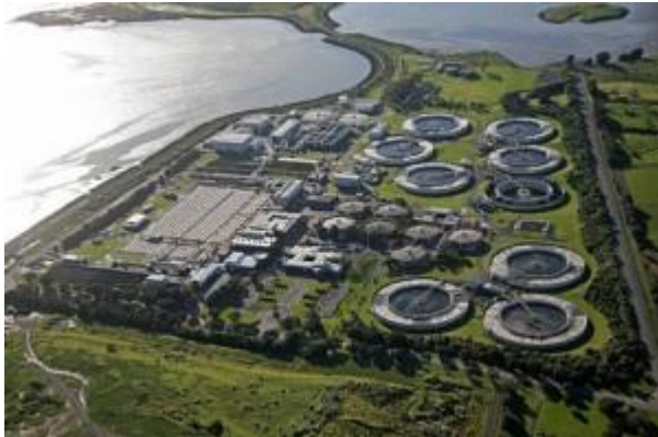
Planta de tratamiento de aguas residuales en Atotonilco..
