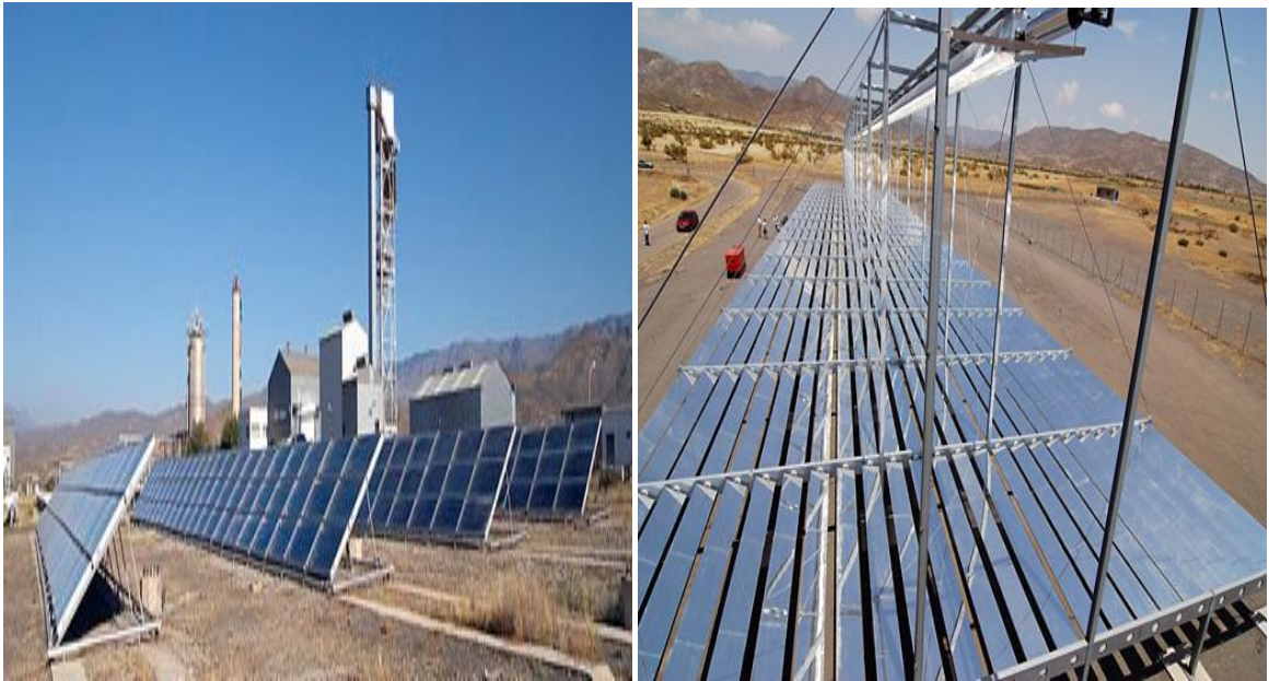
Figura 3.13.- Campo solar con captadores solares estáticos (Fig. izquierda), lazo de conexión de colector de demostración Fresnel lineal MAN en Almería. (Fig.derecha).
