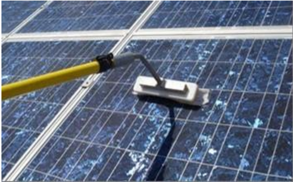
Figura 4.10.- Limpieza de paneles.
