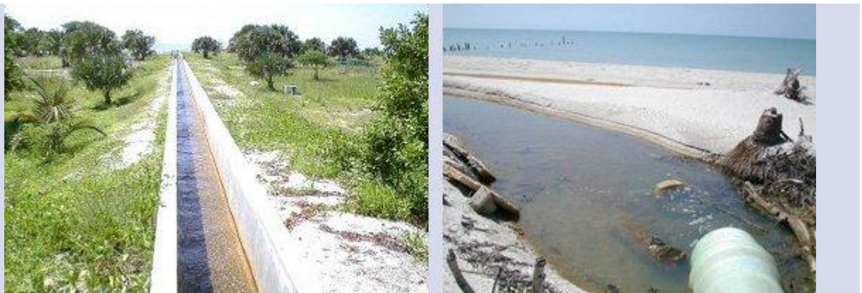
Figura 4.2.- Descarga de salmuera al mar, desde una desaladora.
