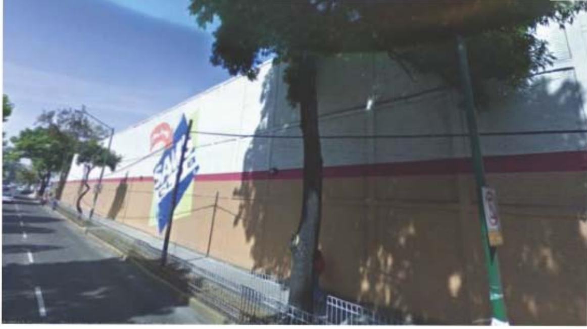
FIGURA 7 Muro de tienda Sam's Club en Villa Coapa
