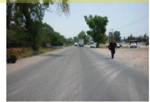
Vista norte de la Calle Interceptor Poniente. Esta calle cuenta con dos carriles y es poco transitada.
