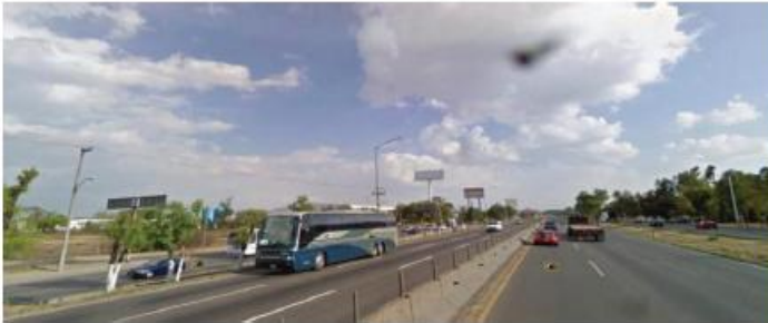
La autopista México-Querétaro consta de 2 carriles para cada sentido.
