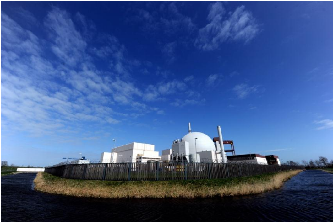
Imagen. 1 Das Kernkraftwerk in Brokdorf soll laut einem EU-weiten Stresstest mit unzulänglichen Erdbebenwarnsystemen ausgerüstet sein. (© dpa) 124
