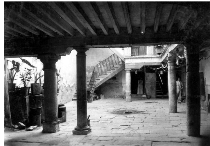
Patio de una Vecindad en el Centro
