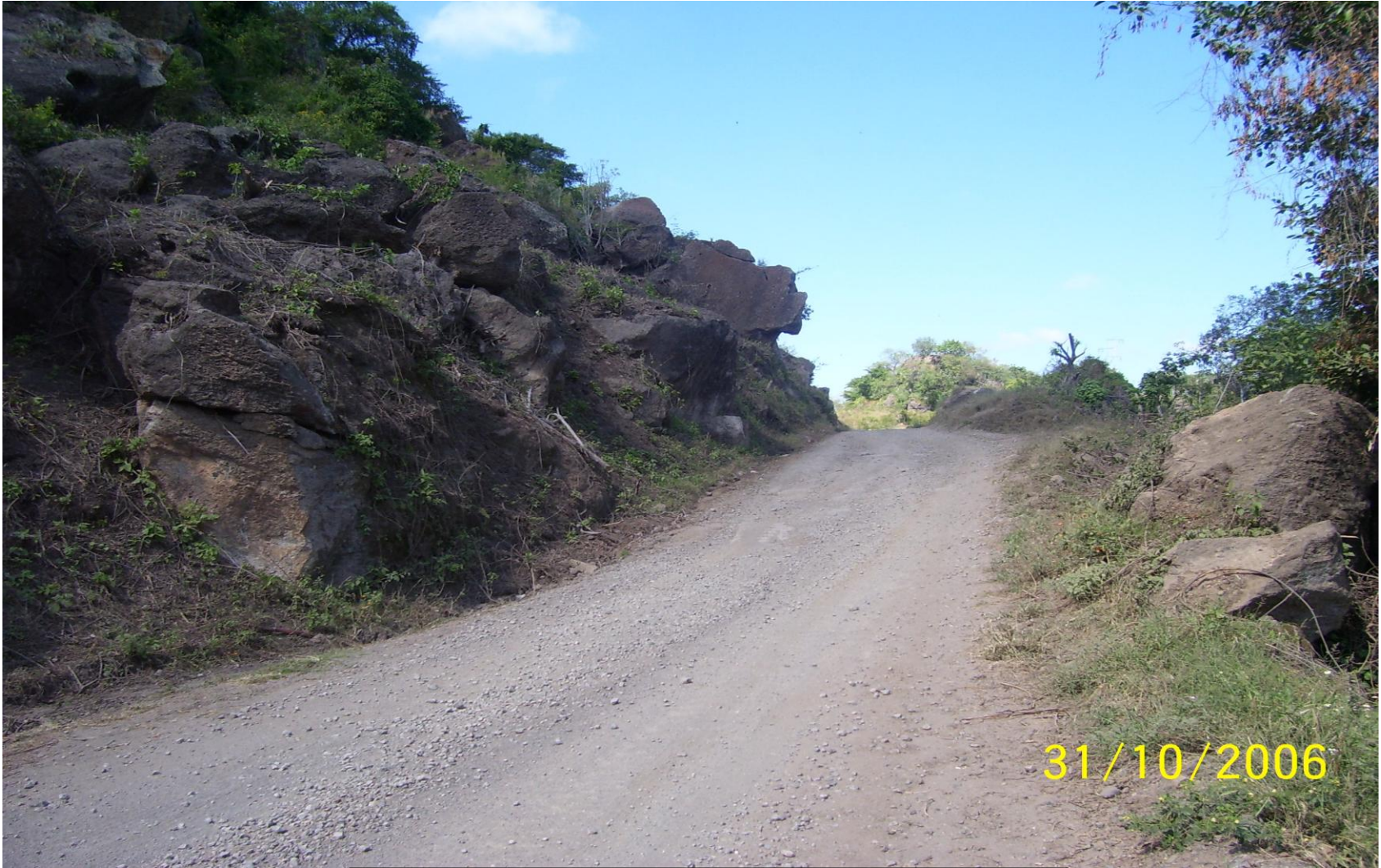
CAMINO DE ACCESO PREVIO A AMPLIACIÓN
