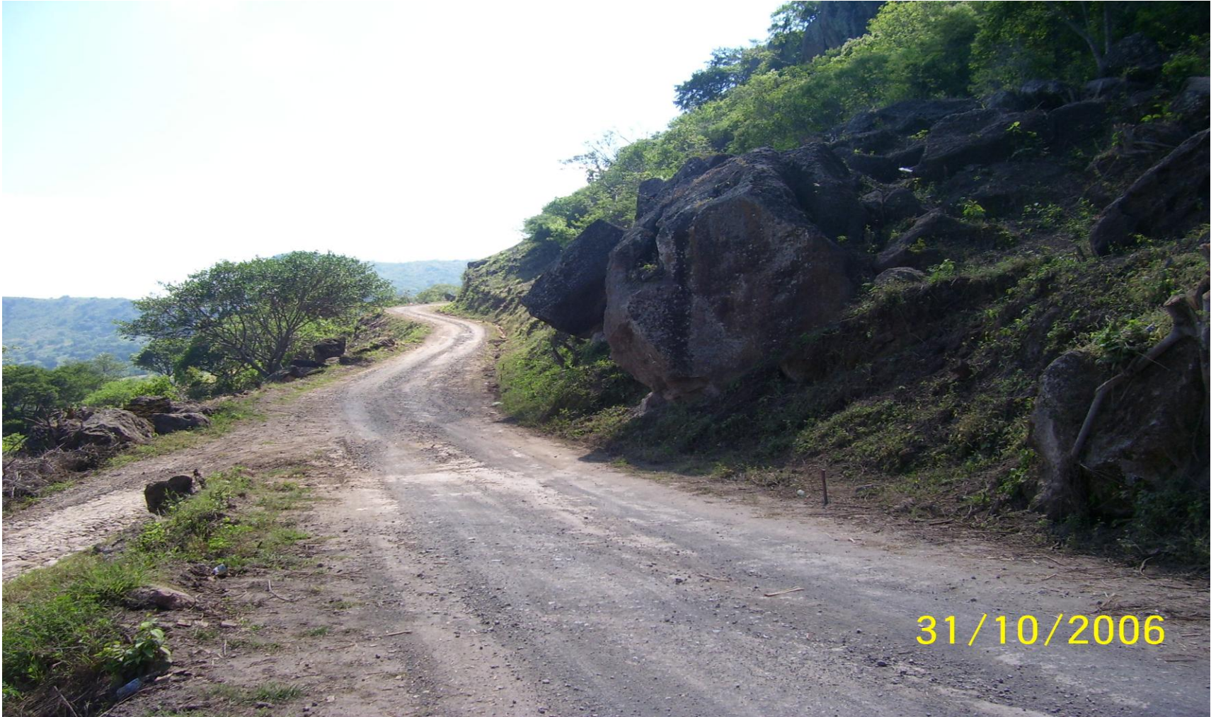
CAMINO DE ACCESO PREVIO A AMPLIACIÓN
