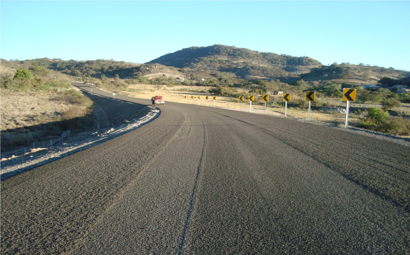
MANTEO DE CARPETA ASFÁLTICA Y SEÑALAMIENTO PREVENTIVO
