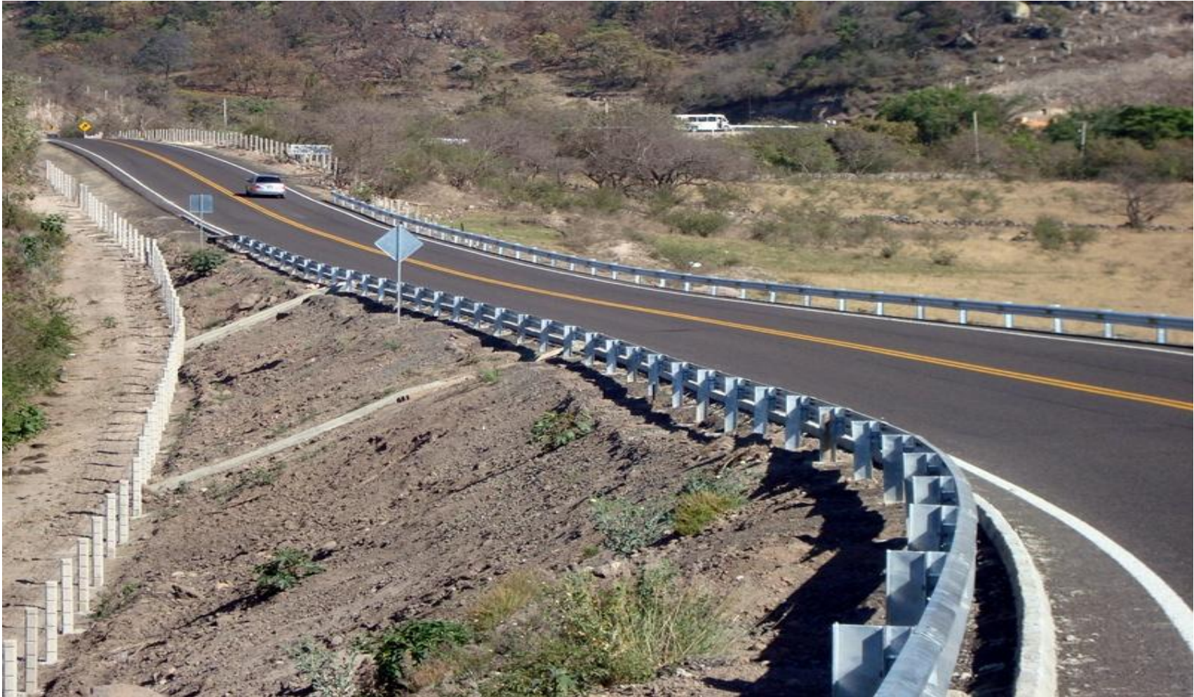
VALIZAMIENTO, SEÑALIZACION Y DEFENSAS METÁLICAS
