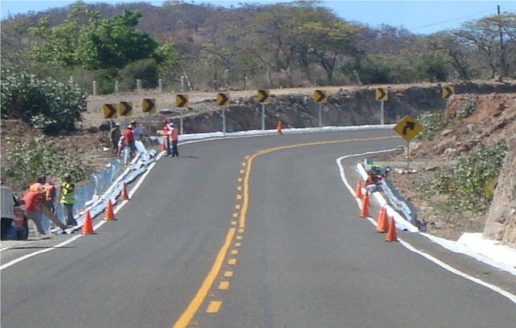
INSTALACIÓN DE BALLAS METÁLICAS
