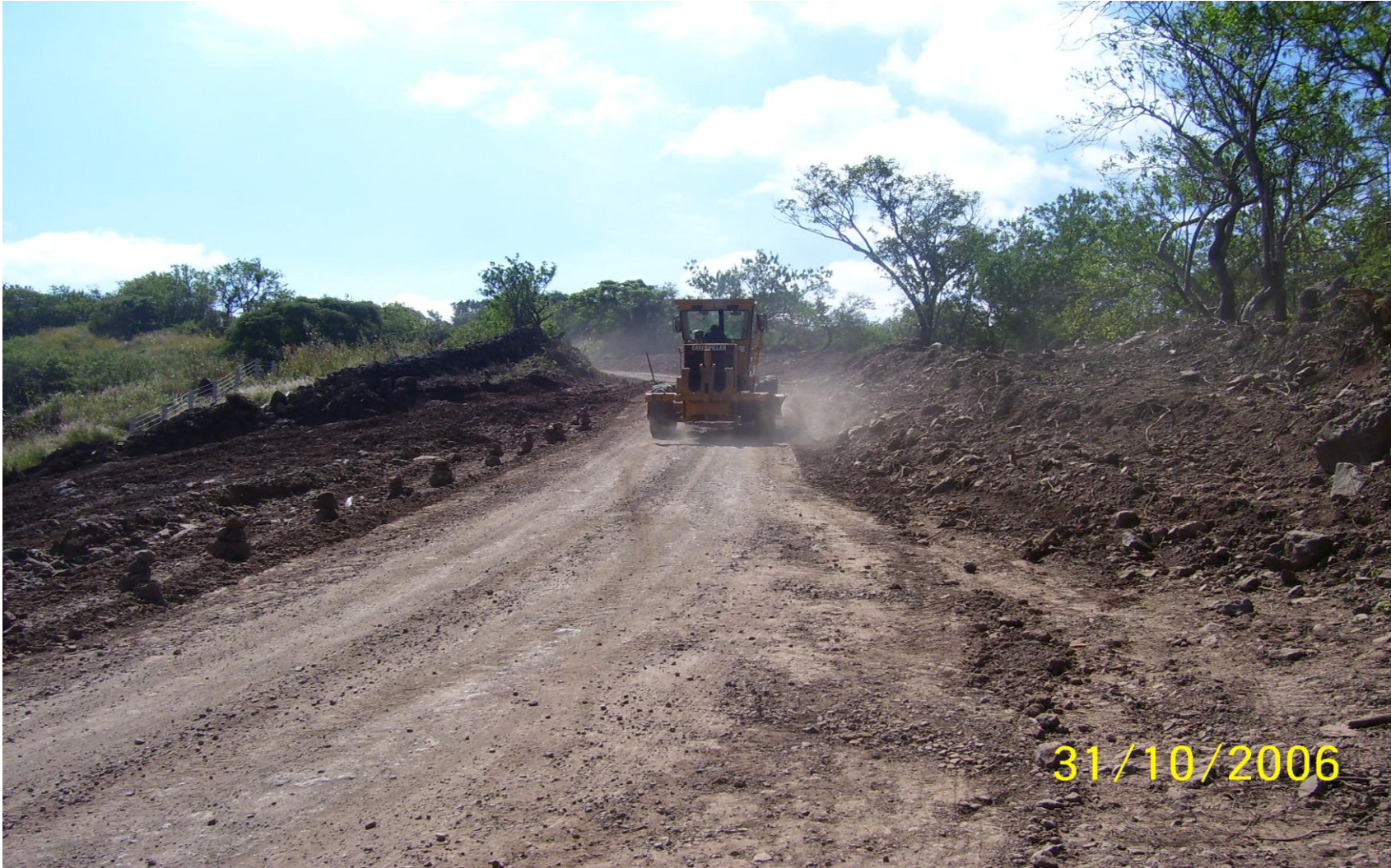
MOTOCONFORMADORA REALIZANDO NIVELACIÓN
