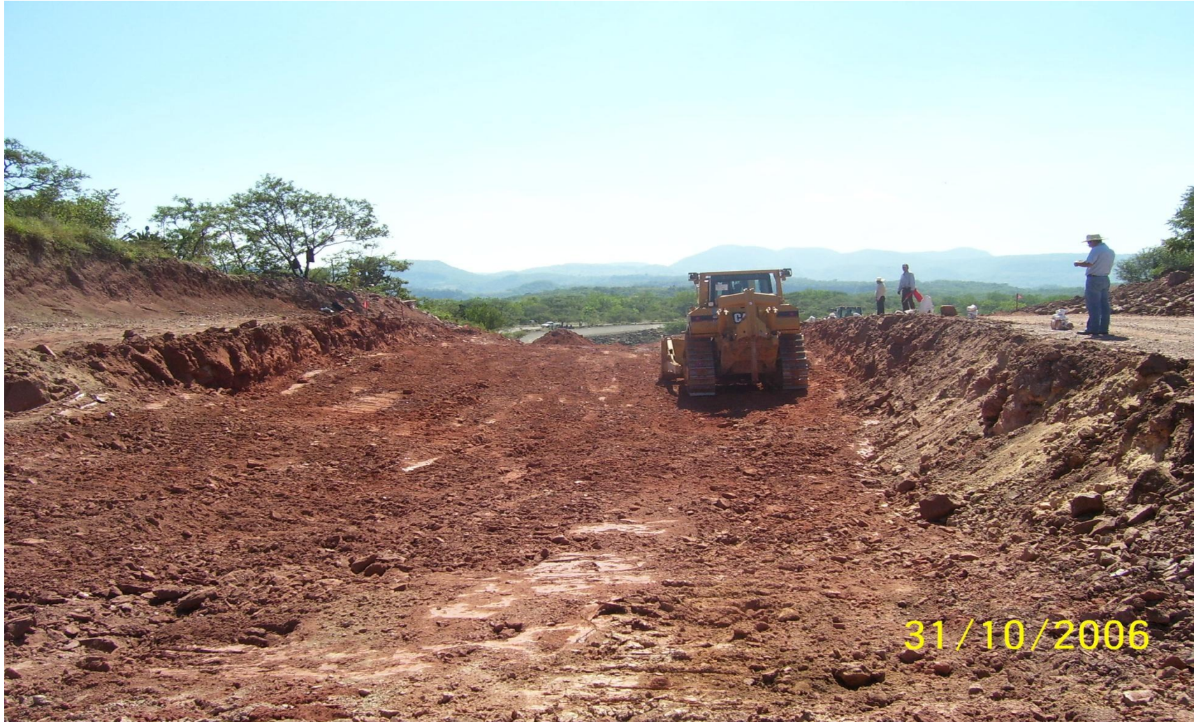
EMPUJE DE MATERIAL DESPUÉS DE UTILIZAR EL RIPER PARA LIMPIEZA DEL TERRENO
