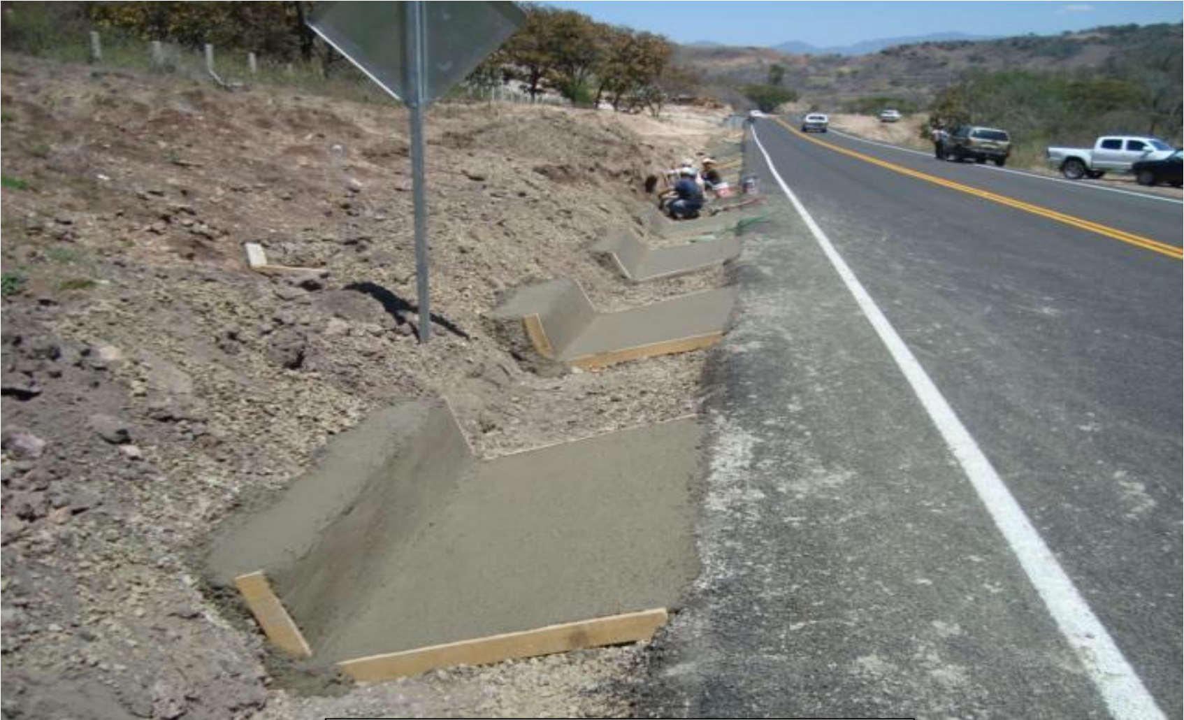
CONSTRUCCIÓN DE CUNETAS Y LIMPIEZA
