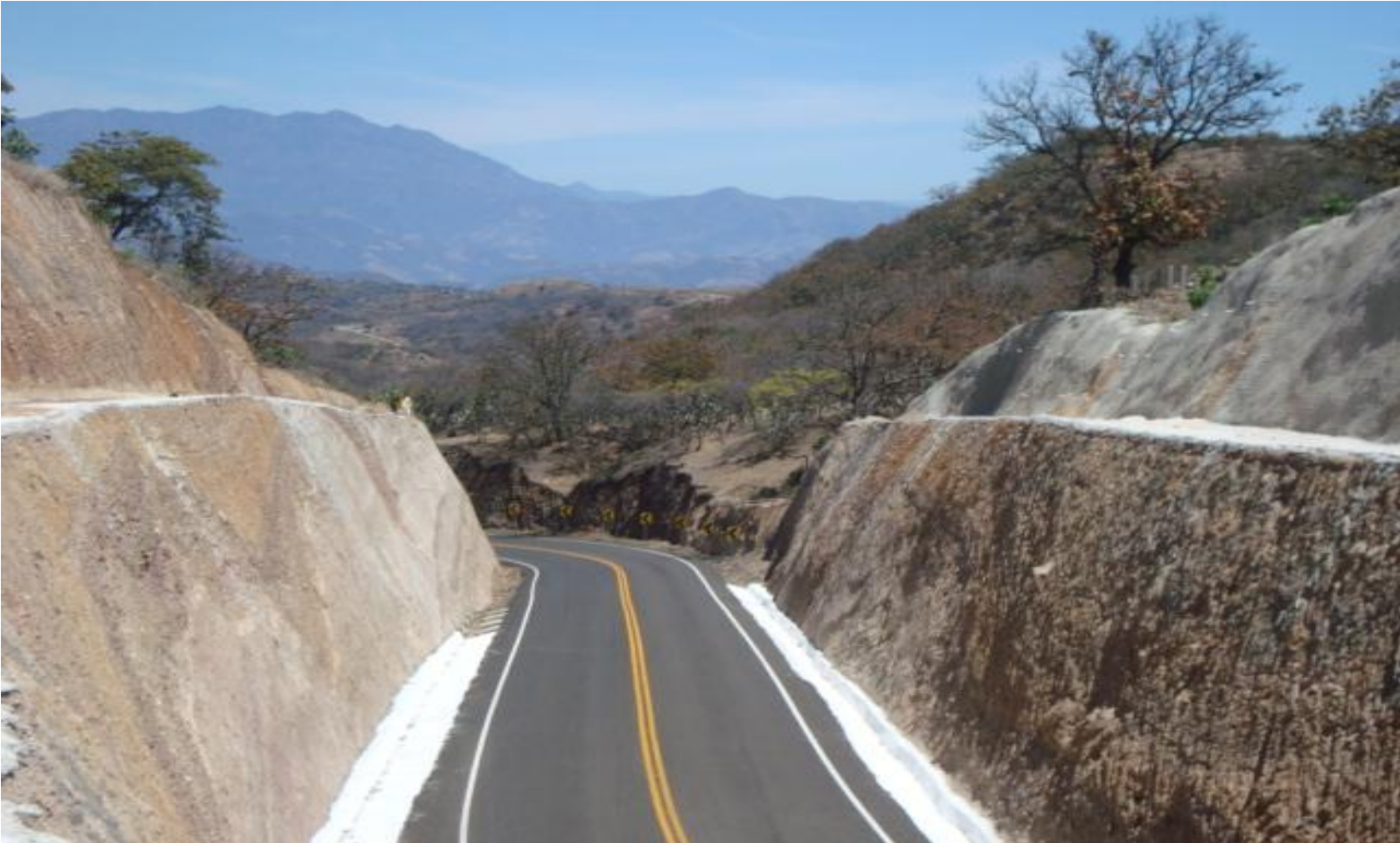
RECUBRIMIENTO DE TALUDES CON PIEDRA Y CONCRETO LANZADO EN LA PARTE SUPERIOR
