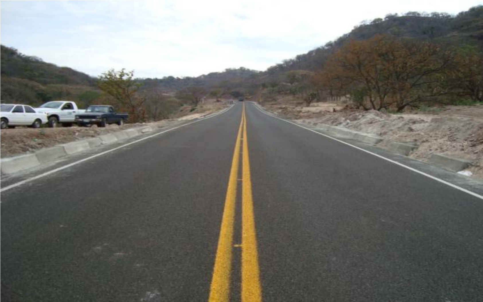
PISO DE PAVIMENTO TERMINADO DE LA CINTA ASFÁLTICA
