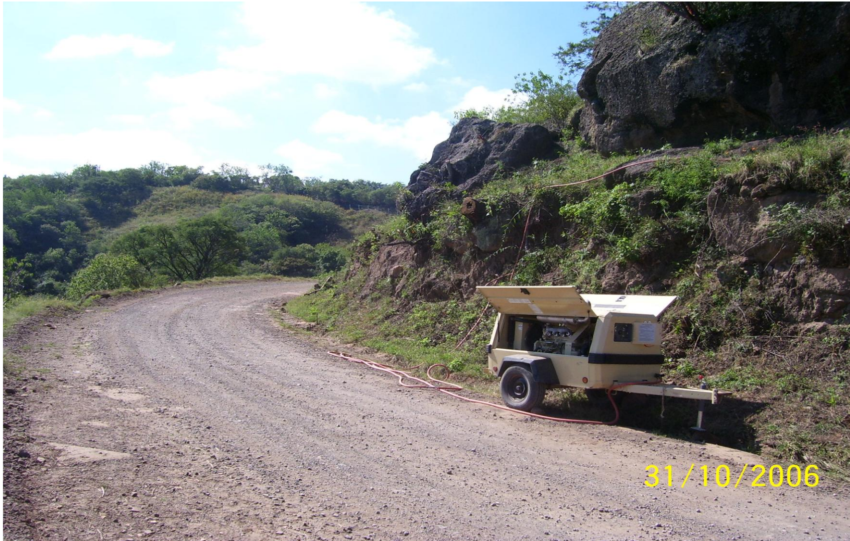
USO DE COMPRESOS PARA ROMPER ROCAS
