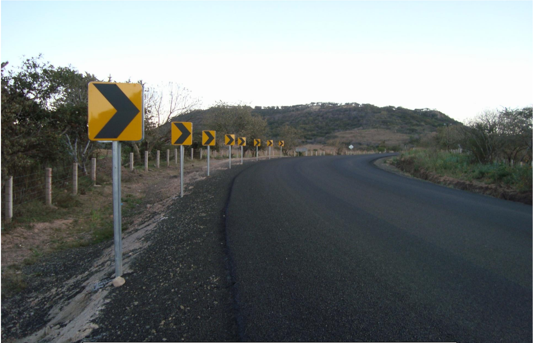
MANTEO DE CARPETA ASFÁLTICA Y SEÑALAMIENTO PREVENTIVO
