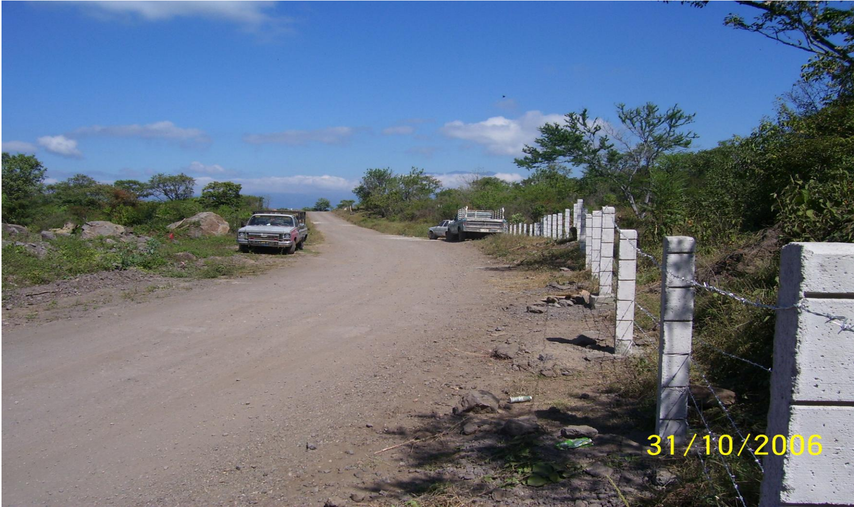
CAMINO DE ACCESO PREVIO A AMPLIACIÓN
