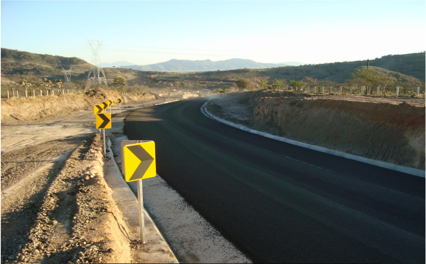
MANTEO DE CARPETA ASFÁLTICA Y SEÑALAMIENTO PREVENTIVO
