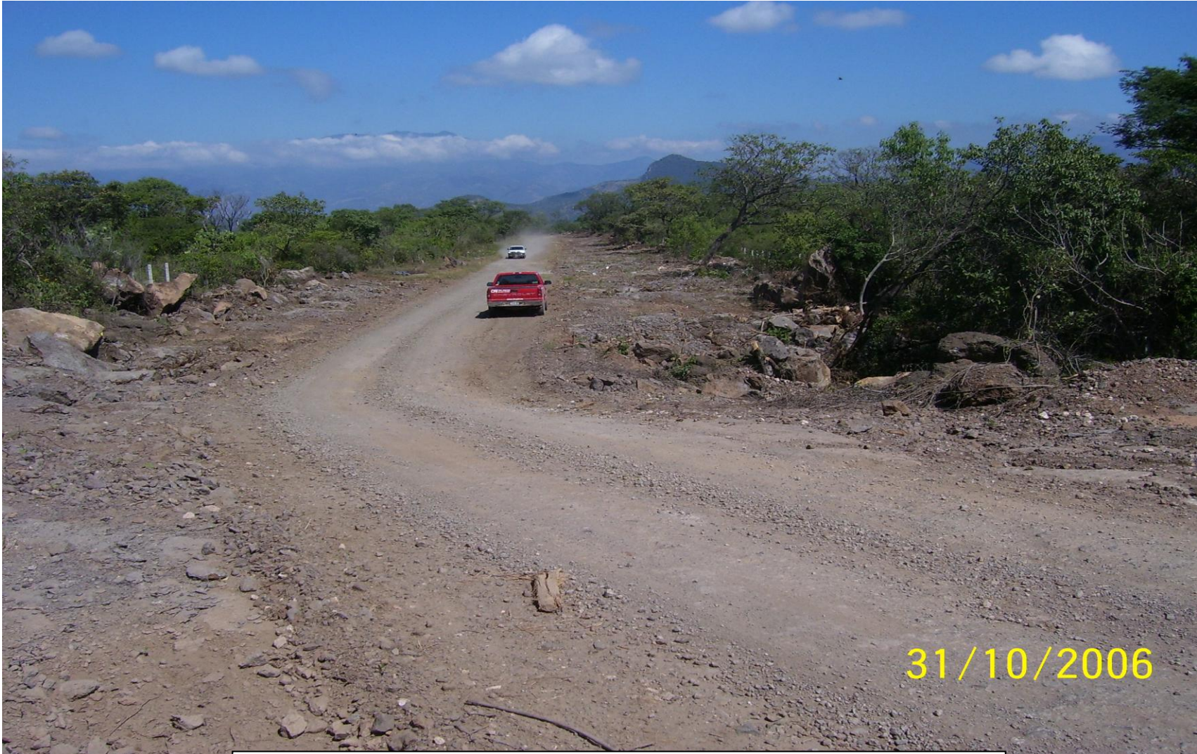
AMPLIACIÓN REALIZADA AL CAMINO YA EXISTENTE
