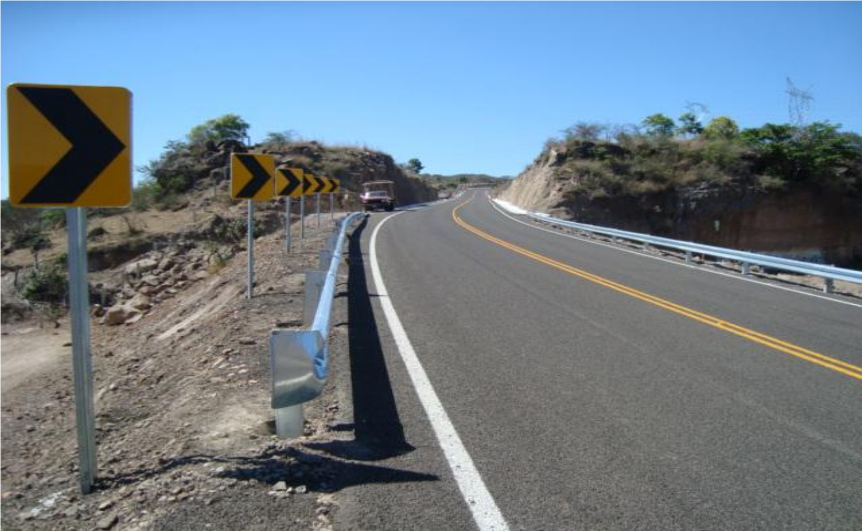
INSTALACIÓN DE BALLAS METÁLICAS Y SEÑALAMIENTO PREVENTIVO.
