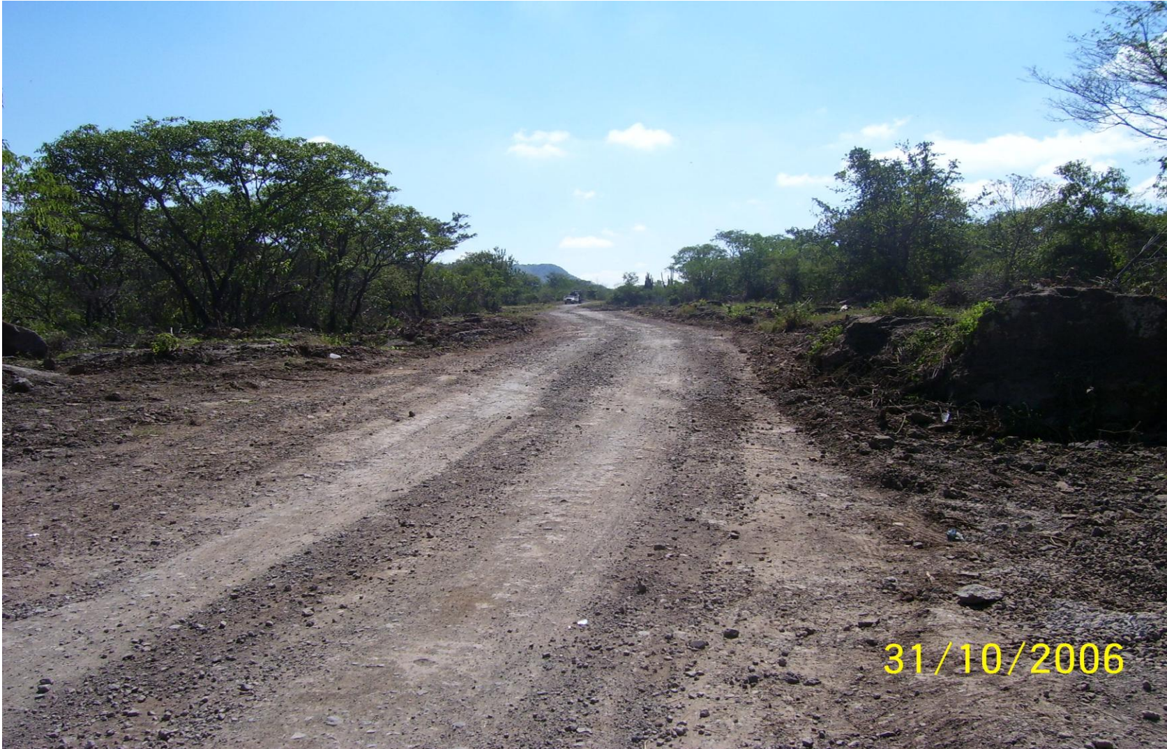
AMPLIACIÓN REALIZADA AL CAMINO YA EXISTENTE
