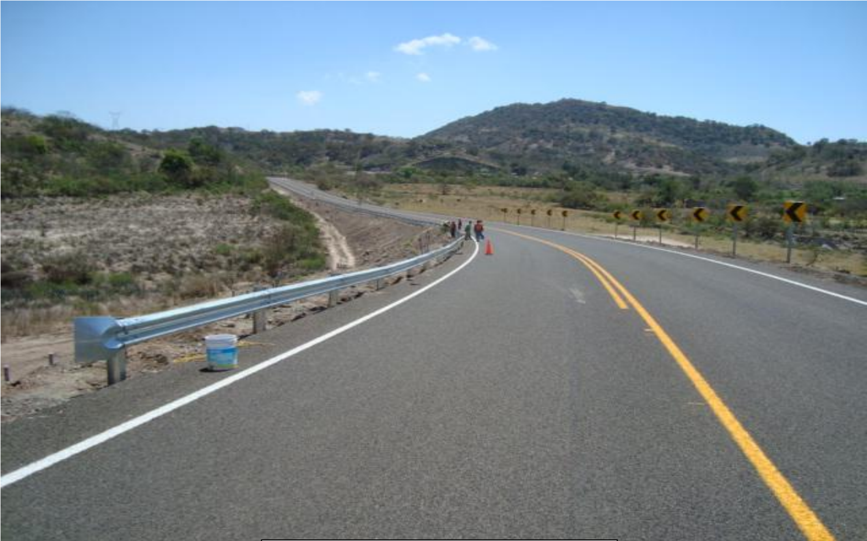
INSTALACIÓN DE DEFENSA METÁLICA
