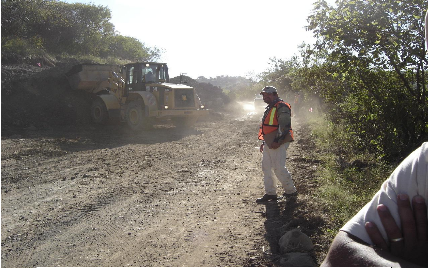
CARGADOR FRONTAL SOBRE NEUMÁTICOS, APILANDO MATERIAL DE CORTES
