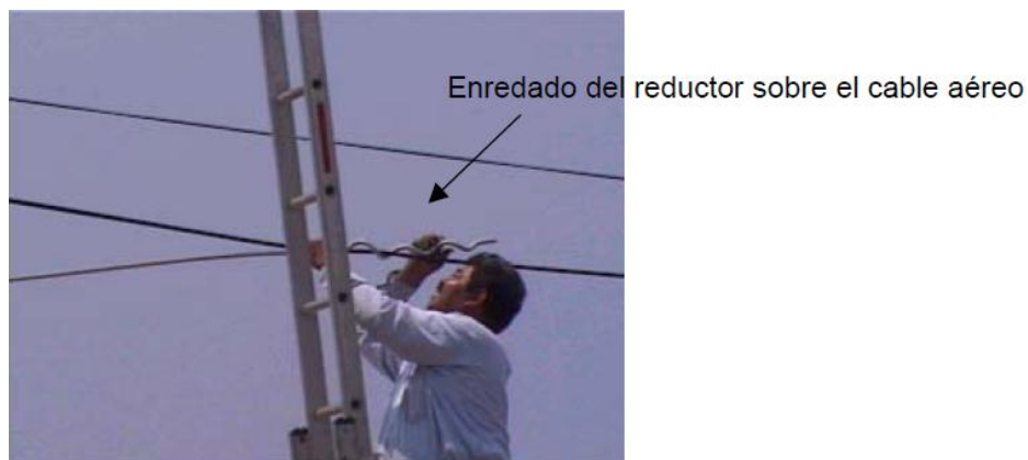
Figura 2.32 Fijación de sección de agarre.
