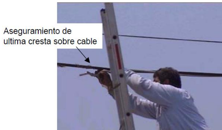
Figura 2.34 Fijación de crestas lado opuesto.
