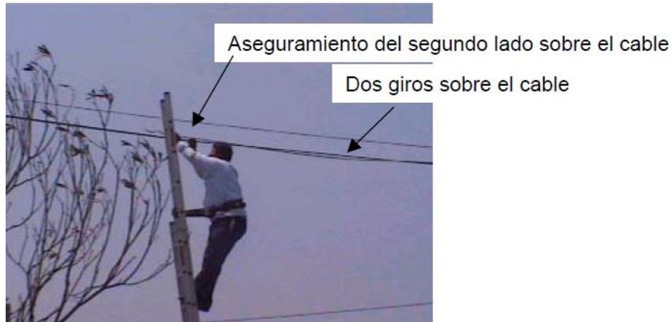
Figura 2.33 Acomodo de la sección de amortiguamiento.
