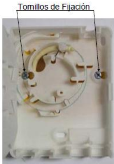
Figura 3.13. Fijación de la Roseta óptica.
