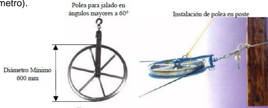
Figura 2.16 Polea para jalado en línea recta o cambios de dirección menores a 30 grados.
