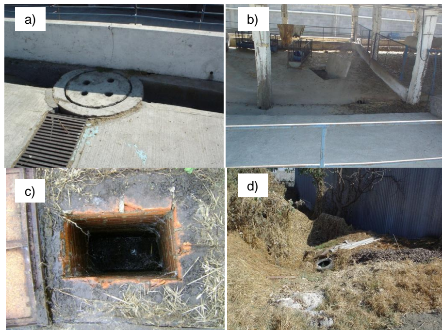
Figura 4.3 Descarga de agua residual. (a) Registro de agua residual de corrales de hato ovino y caprino; (b) desagüe de agua residual de corrales de hato ovino, caprino y quesería; (c) registro de agua residual de hato bovino; (d) desagüe de agua residual de corrales bovino.
