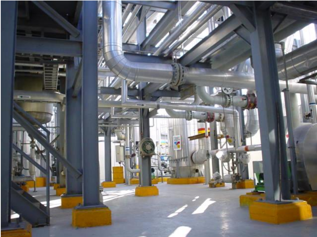
Empresa Detergentes y Jabones Sasil, S.A. de C.V. Planta Monterrey, Reactor de transformación de azufre, Mayo 2009.
